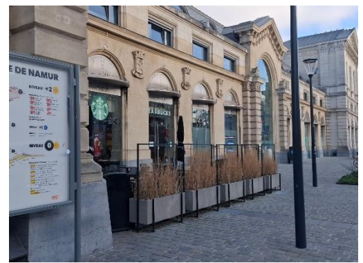
Figure 5-5 : Photographie de la délimitation entre l'espace public et l'espace semi-public, C. Collin, 5 décembre 2025.
