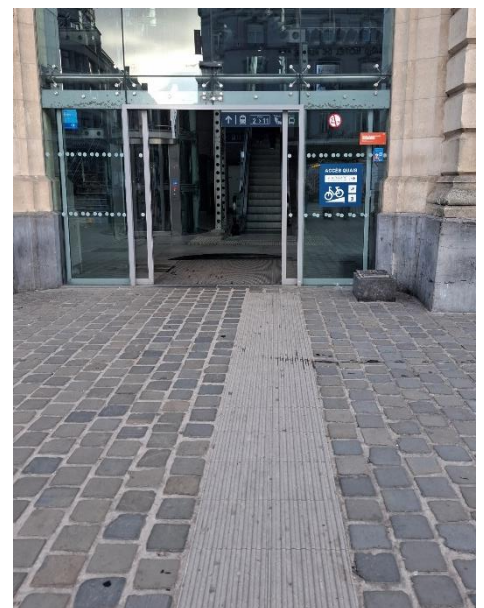
Figure 5-5 : Photographie de dalles podotactiles menant tout droit sur une porte, C. Collin, 5 décembre 2025.
