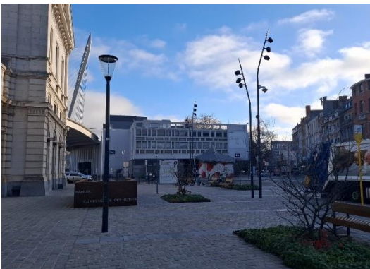
Figure 5-3 : Photographie des deux types de lampadaires présents sur la place de la Station, C. Collin, 5 décembre 2025.
