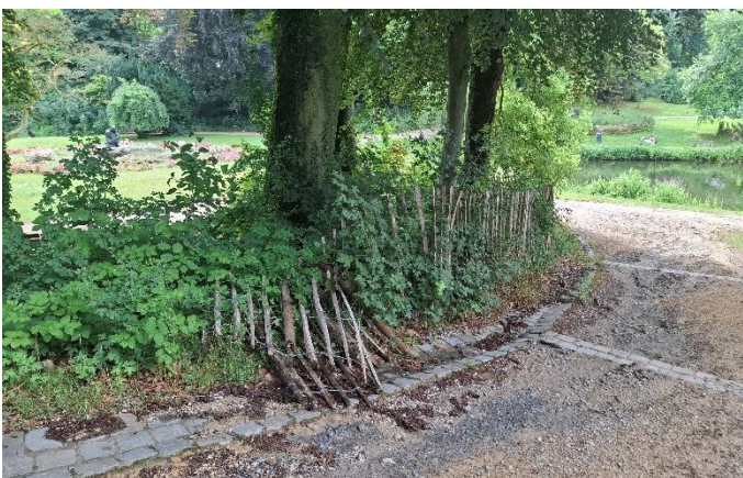
Figure 5-213 : Photographie d'une clôture en châtaignier présentant des dégâts, C. Collin, le 16 juillet 2025.
