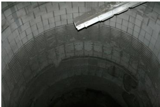
Figure 3.11 – Intérieur du HF B (© V. Duseigne & S. De Wilde, 2009)
