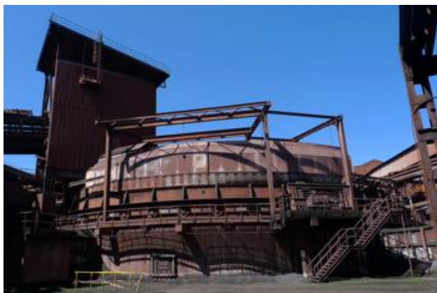
Figure 3.24 – Extérieur de l'installation de refroidissement de l'aggloméré ou carrousel (© V. Duseigne & S. De Wilde, 2009)
