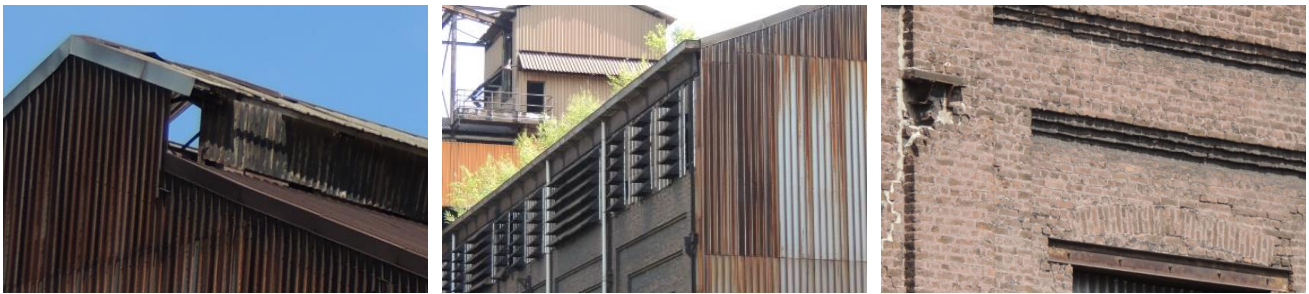
Figure 8.16 – Détails des toitures et des façades du hall maçons (Photos de l'auteur, 2017)
