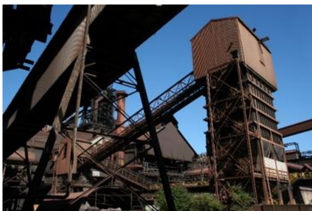
Figure 3.4 – Vue sur des bandes transporteuses, trémies et conduites depuis le sol (© V. Duseigne & S. De Wilde, 2009)
