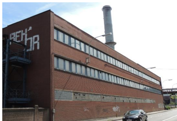
Figure 5.4 – Bâtiment administratif (Photo de l'auteur, 2017)
