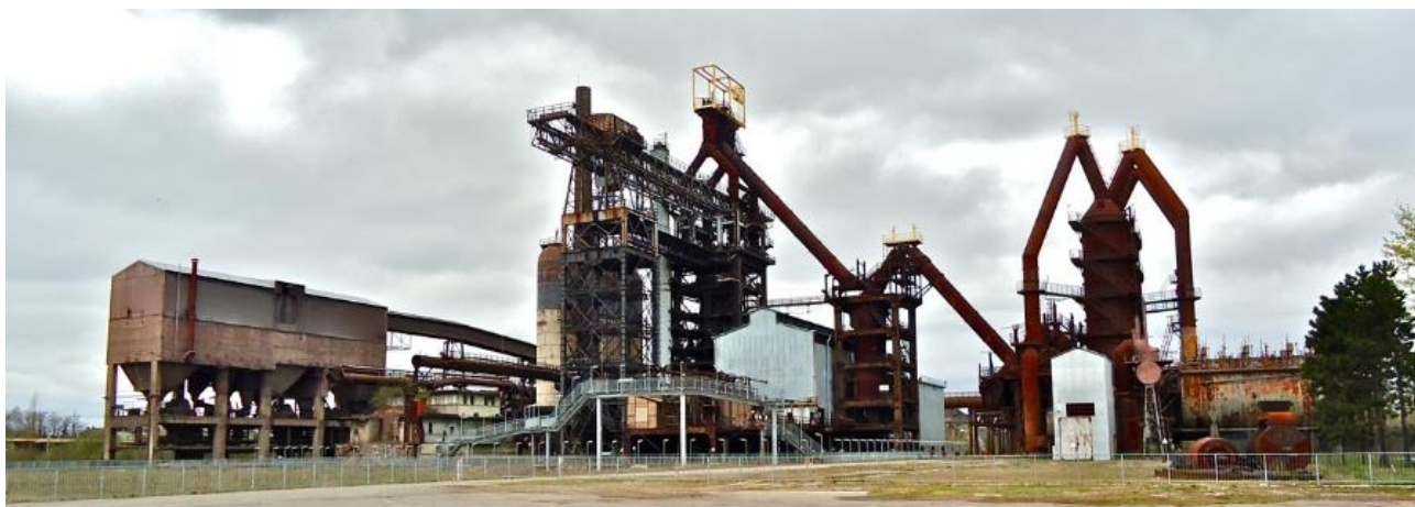
Figure 4.1 – Haut-fourneau U4 d’Uckange et ses bâtiments annexes (© Olivier Lievin)
