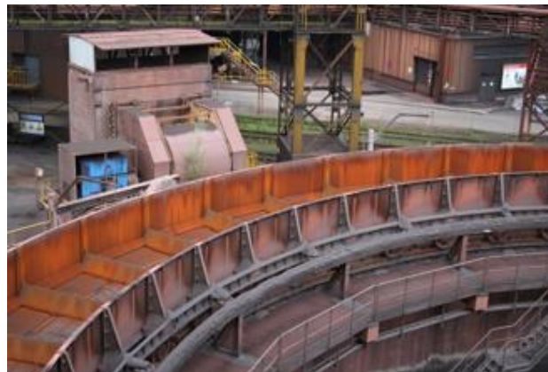
Figure 3.25 – Intérieur de l'installation de refroidissement de l'aggloméré ou carrousel (© V. Duseigne & S. De Wilde, 2009)
