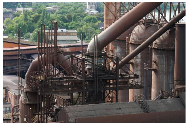
Figure 3.18 – Downcomer connecté au sac à poussières (© V. Duseigne & S. De Wilde, 2009)
