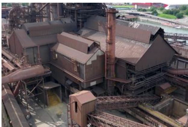
Figure 3.13 – Halles de coulée du HF B vues depuis le bâtiment énergie (© V. Duseigne & S. De Wilde, 2009)
