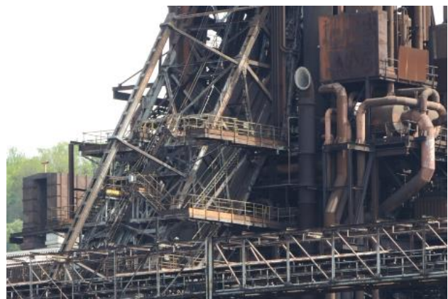
Figure 3.10 – Rampe de chargement du HF B (Photo de l'auteur, 2017)
