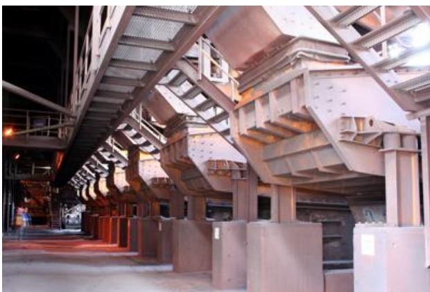
Figure 3.9 – Trémies de chargement du HF B (© V. Duseigne & S. De Wilde, 2009)
