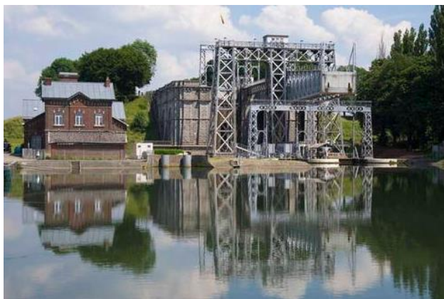
Figure 1.8 – Ascenseurs du canal du centre (© M & G Therin-Weise)
