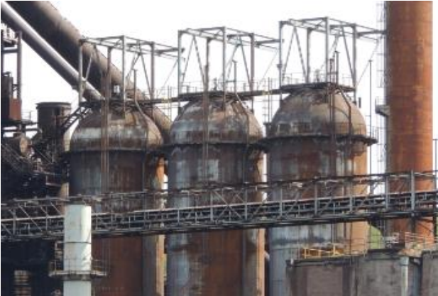
Figure 3.15 – 3 cowpers du haut-fourneau B (Photo de l'auteur, 2017)
