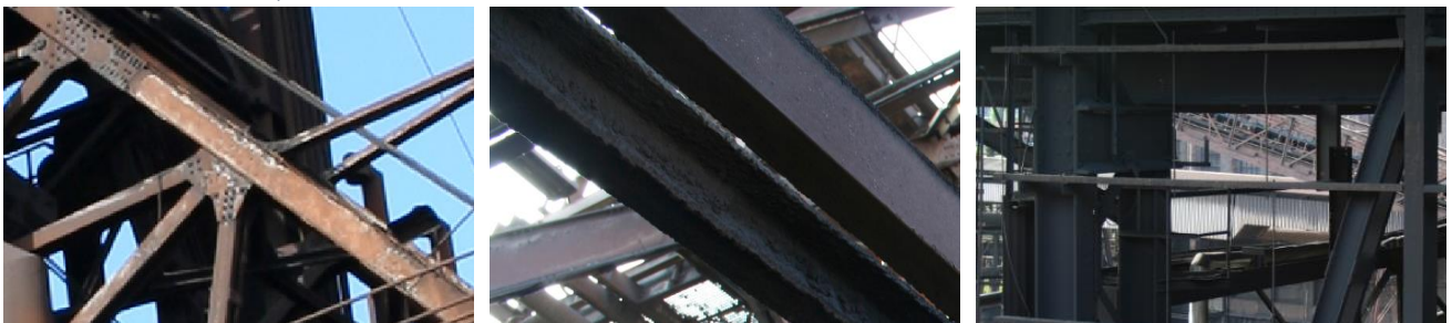
Figure 8.2 – Détails de la structure portante du haut-fourneau B (© V. Duseigne & S. De Wilde, 2009)
