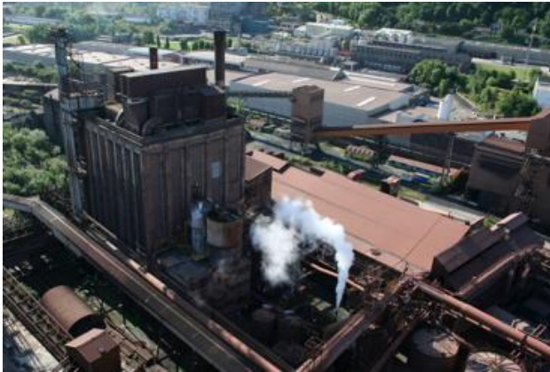
Figure 3.26 – Hall énergie et bâtiment chaudières vus depuis le haut-fourneau B (© V. Duseigne & S. De Wilde, 2009)
