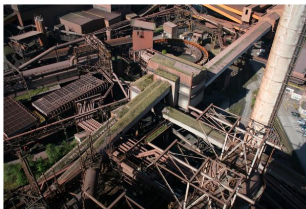
Figure 3.5 – Vue sur des bandes transporteuses, trémies et conduites depuis le HF B (© V. Duseigne & S. De Wilde, 2009)
