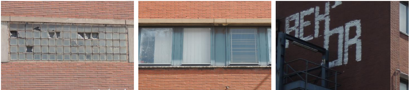
Figure 8.19 – Détails des façades et menuiseries du bâtiment administratif (Photos de l'auteur, 2017)
