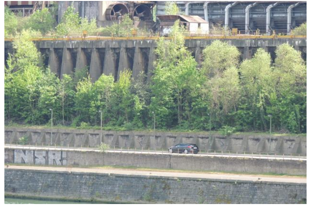
Figure 3.33 – Grands accumulateurs à minerais (Photo de l’auteur, 2017)
