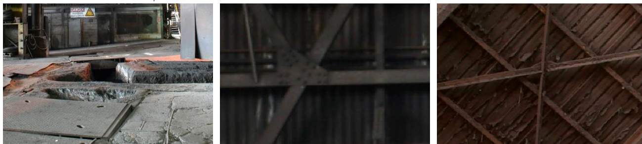
Figure 8.6 – Détails des structures non portantes des halles de coulée (© V. Duseigne & S. De Wilde, 2009)
