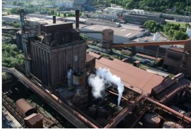
Figure 5.5 – Hall énergie et bâtiment chaudières vus depuis le haut-fourneau B (© V. Duseigne & S. De Wilde, 2009)
