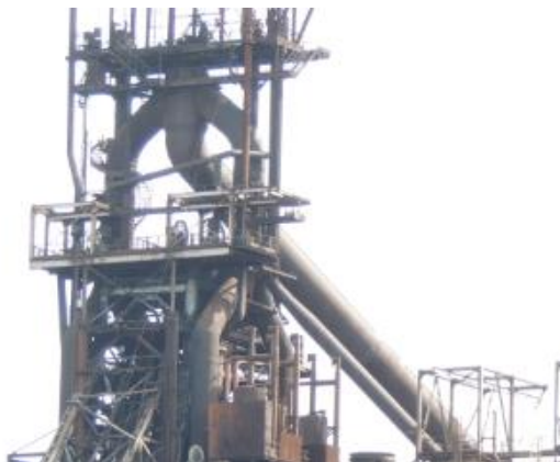
Figure 3.17 – Tuyaux de récupération des gaz et downcomer du HF B (Photo de l'auteur, 2017)
