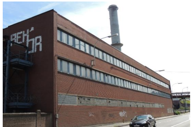
Figure 3.29 – Bâtiment administratif (Photo de l'auteur, 2017)
