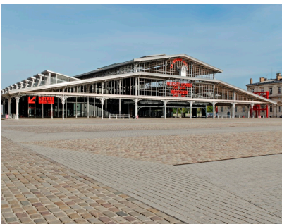
FIGURE 10 - La grande halle de La Villette, Paris, Reichen et Roberts & Associés (Google Images)
