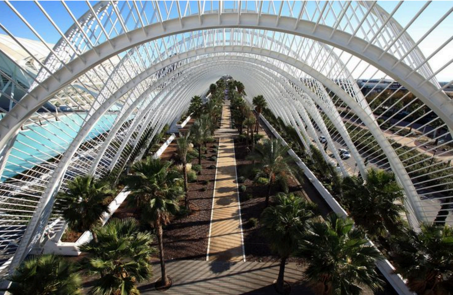
Vue intérieure de Umbracle Figure 52
