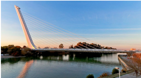
Puente del Alamillo, Séville
