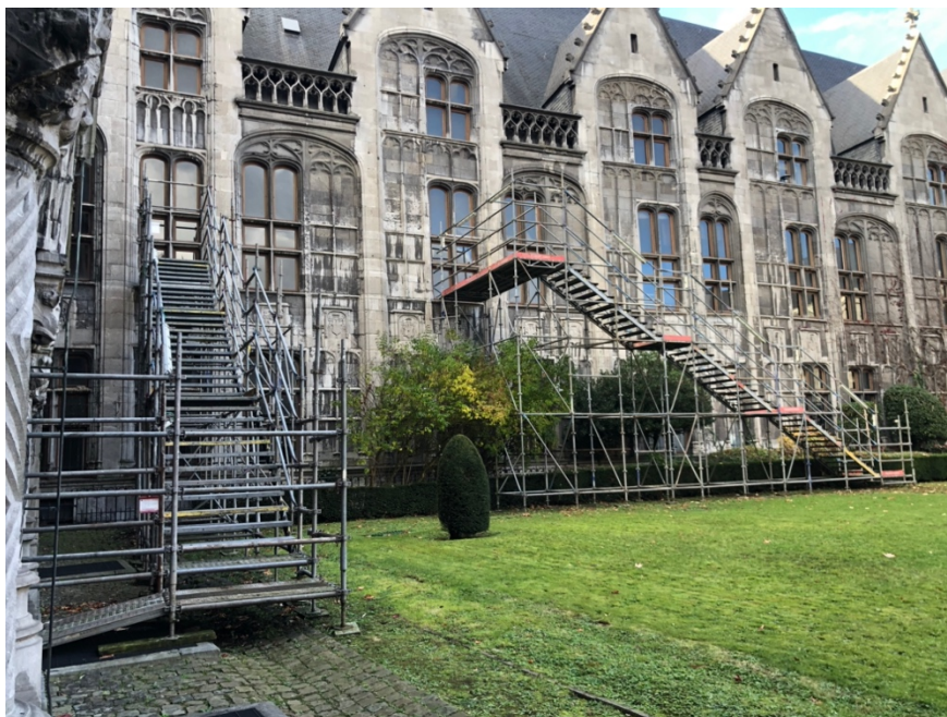
Fig. 86 : Escaliers de secours de la cour d'assises de Liège vus de l'extérieur
