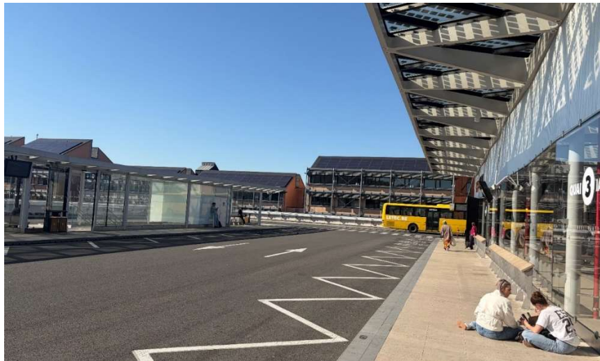
Figure 30: Gare des bus en toiture Source: Roman Avci, 2026
