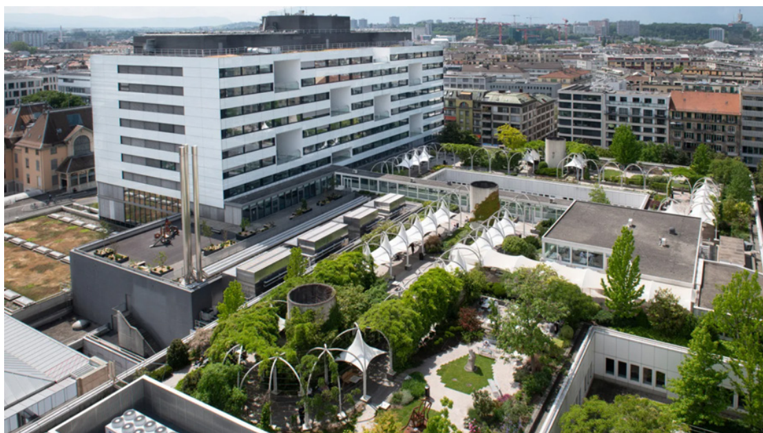
Figure 41: Toitures végétalisées de l'Hôpital cantonal de Genève
