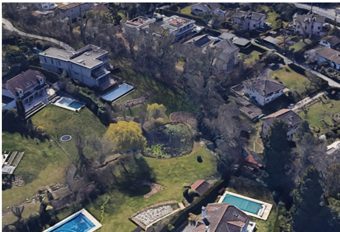
Figure 37 : Bassin de rétention d'eau de pluie dans la banlieue du Chemin du Vieux-Clos, à Genève
