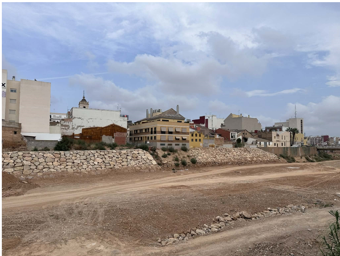
Figure 47 : Restauration et renforcement du lit de la Rambla del Poyo à Paiporta
