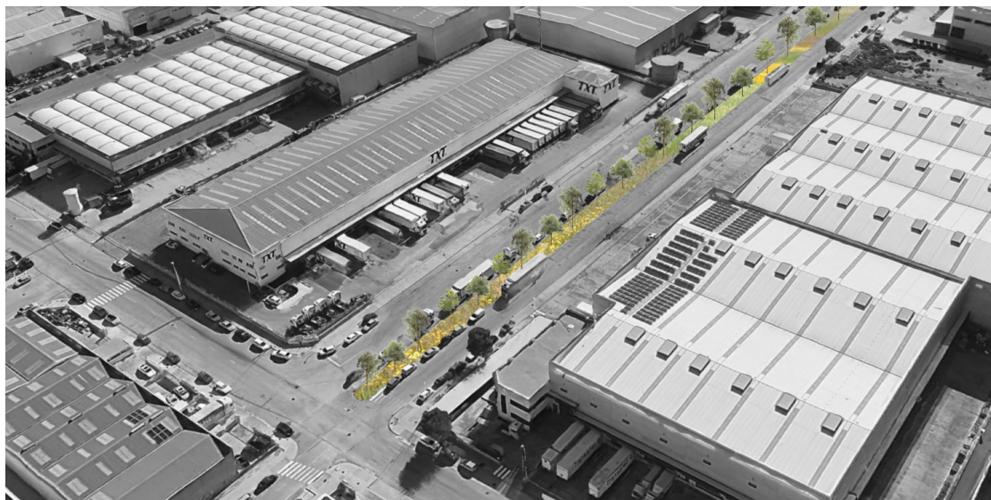
Figure 68 : Voirie dans une zone industrielle en amont de Paiporta équipée d'arbres de pluie
