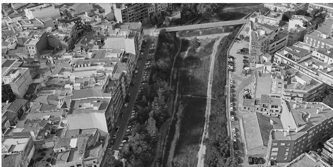
Figure 80 : Perspective du lit de la Rambla del Poyo avant intervention
