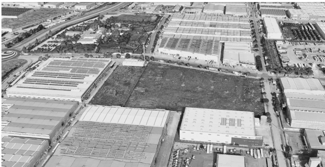
Figure 54 : Parcelle vierge dans zone industrielle en amont de Paiporta
