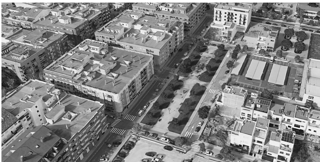
Figure 86 : Perspective du parc rue Torrent avant intervention
