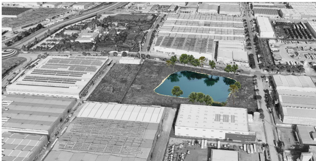
Figure 55 : Zone industrielle en amont de Paiporta équipée d'un bassin de rétention
