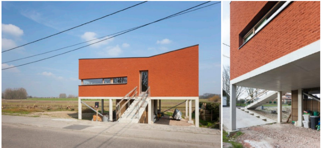
Figures 24 et 25 : Habitation sur pilotis du bureau B-bis architecten
