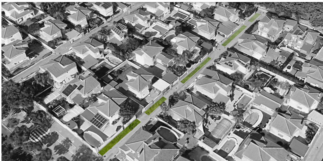
Figure 62 : Quartier résidentiel en amont de Paiporta équipé de noues
