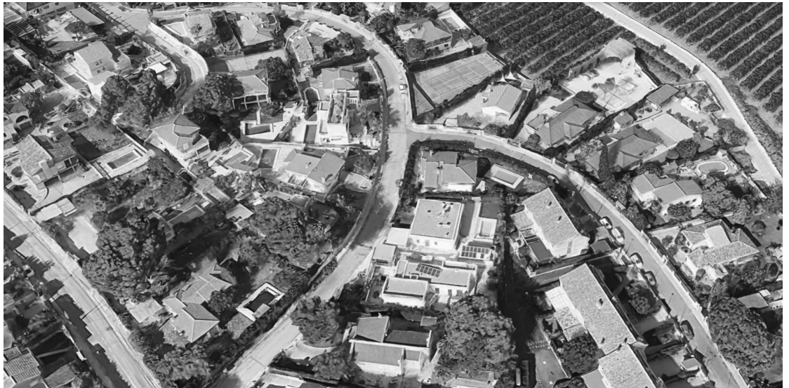
Figure 64 : Logement disposant d'une toiture plate dans un quartier résidentiel en amont de Paiporta
