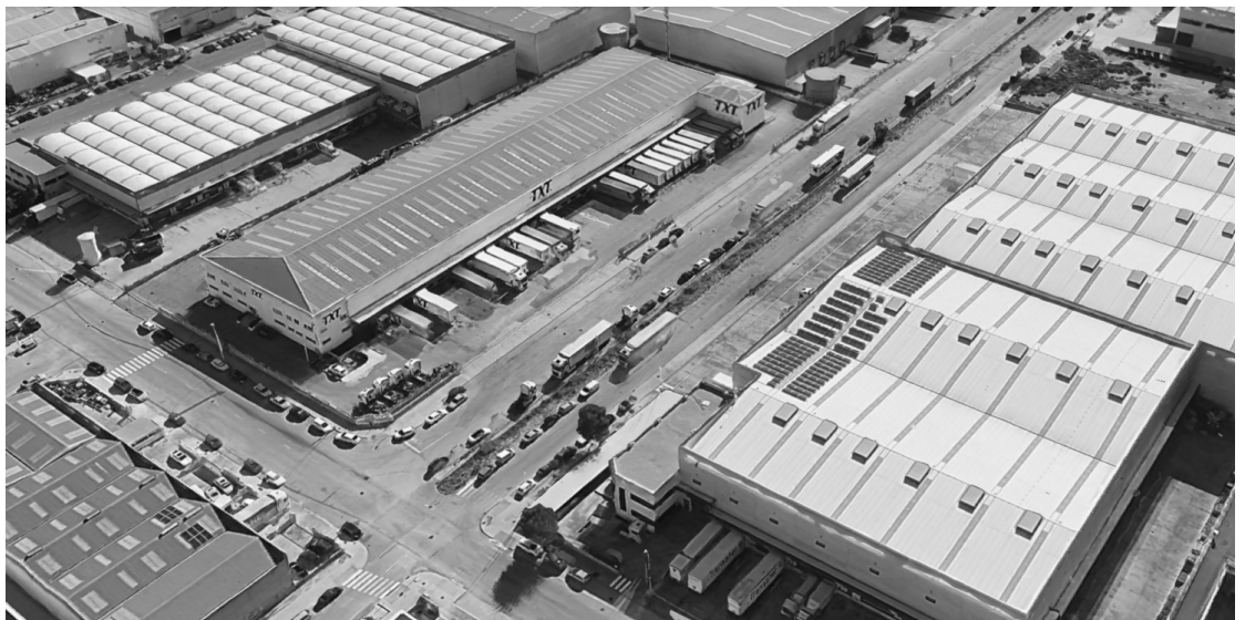
Figure 67 : Voirie dans une zone industrielle en amont de Paiporta
