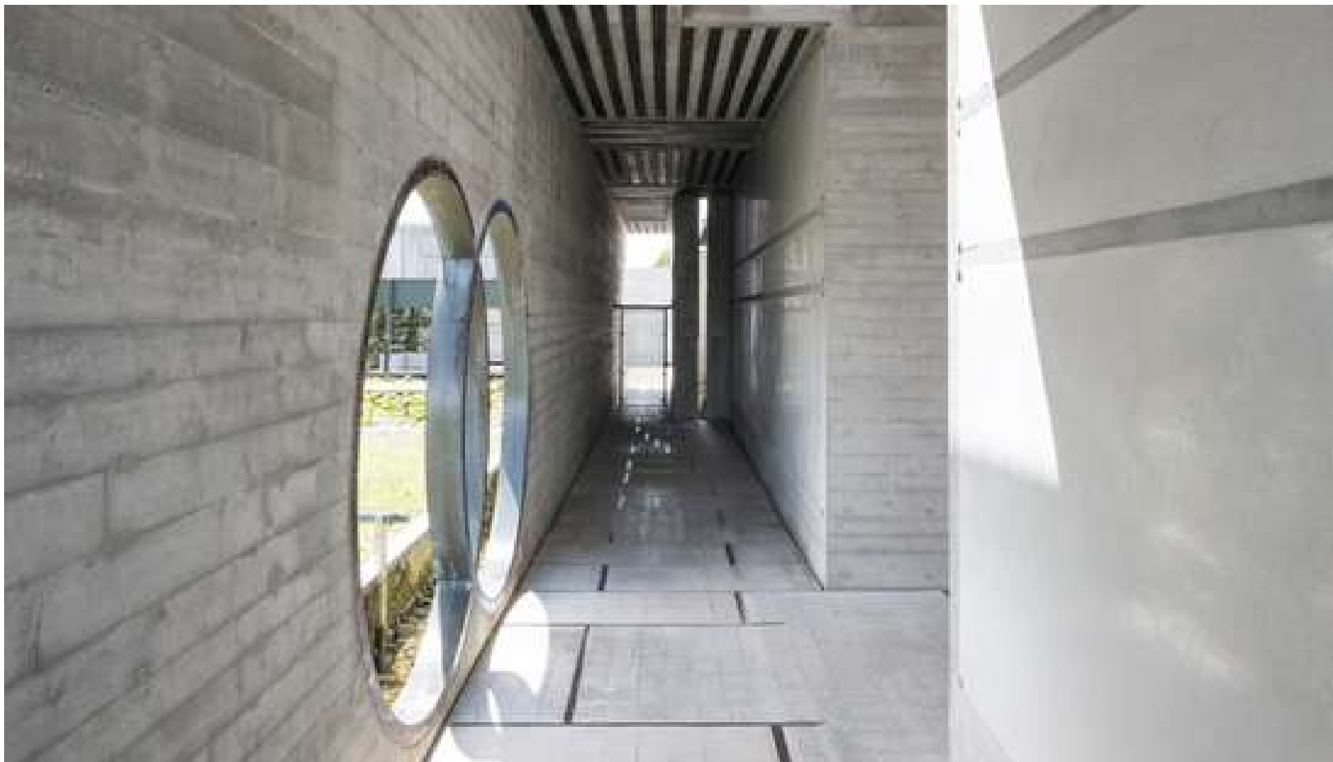
Fig. 166, Tomba Brion (1969-1978) par Carlo Scarpa. Propylaeum, entrée principale. Photographie par Filippo Poli, 2024. Source : hicarquitectura.com
