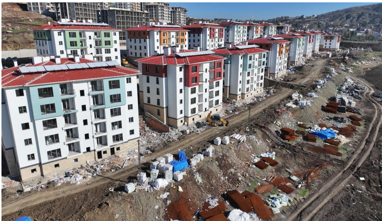
Figure 99. Chantier de reconstruction à Kahramanmaraş mené par TOKİ, montrant la réalisation de logements collectifs standardisés et la structuration d'un nouveau tissu urbain en périphérie. @HamzaKarpuz
