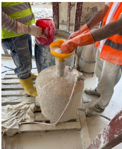
Figure 77. Préparation du mortier à base de chaux pour injection. @SemihMentese
