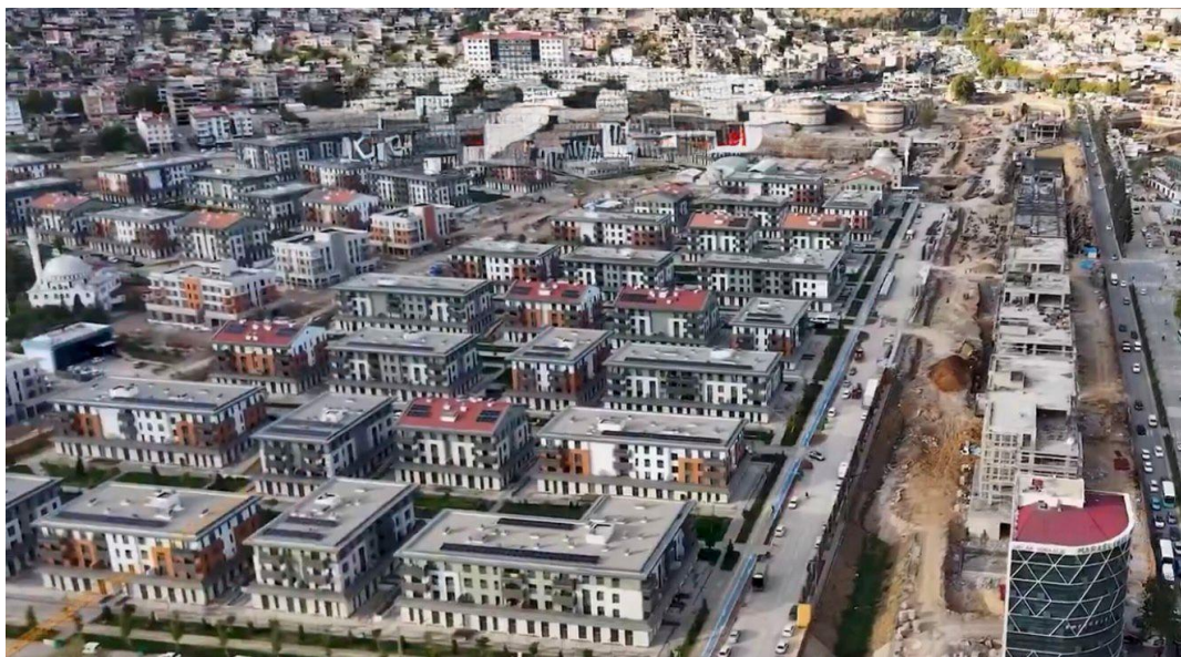
Figure 36. Vue aérienne de l'avenue Azerbaycan à Kahramanmaraş en cours de reconstruction après le séisme du 6 février 2023, illustrant la reconstitution du tissu urbain selon une organisation planifiée et homogène. @Ministère de l'Intérieur de la République de Turquie
