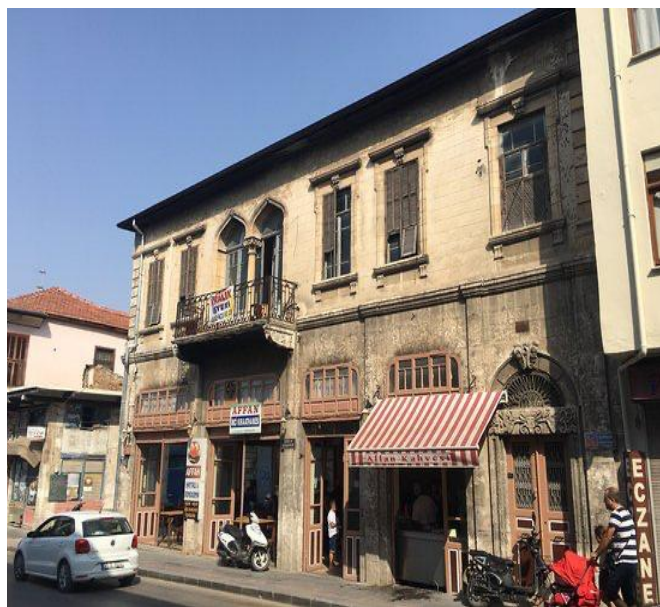
Figure 68. Façade du café Affan, établissement historique du centre ancien, illustrant l'état du bâti avant les destructions liées au séisme de 2023. @szgnbsl
