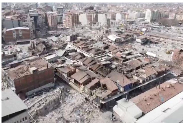
Figure 42. Vue aérienne des destructions du marché des chaudronniers (Bakırcılar Çarşısı, Malatya) après le séisme du 6 février 2023. @Sabah
