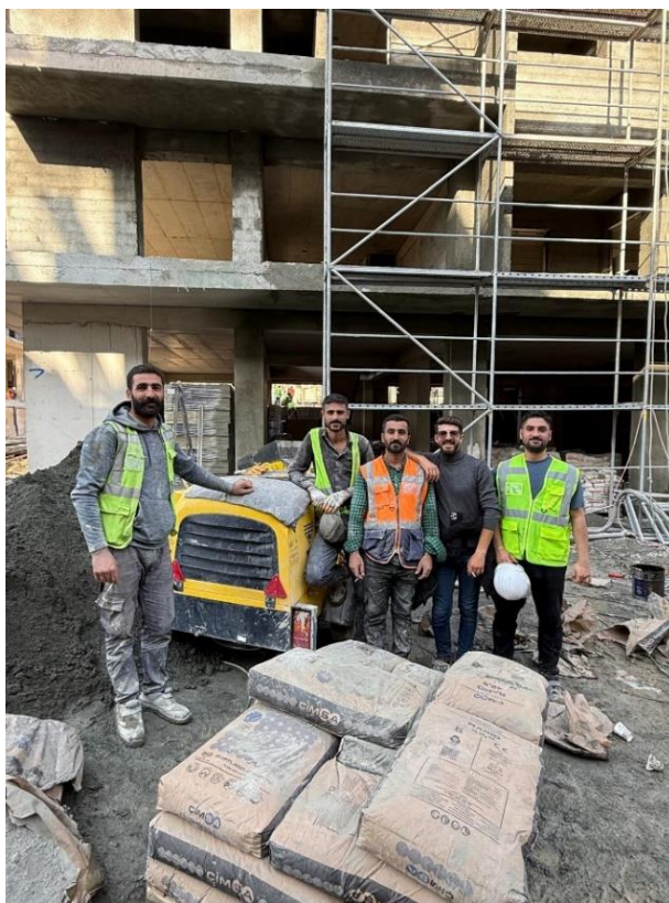
Figure 63. Équipe d'ouvriers intervenant dans la mise en œuvre du chantier. @SemihMentese
