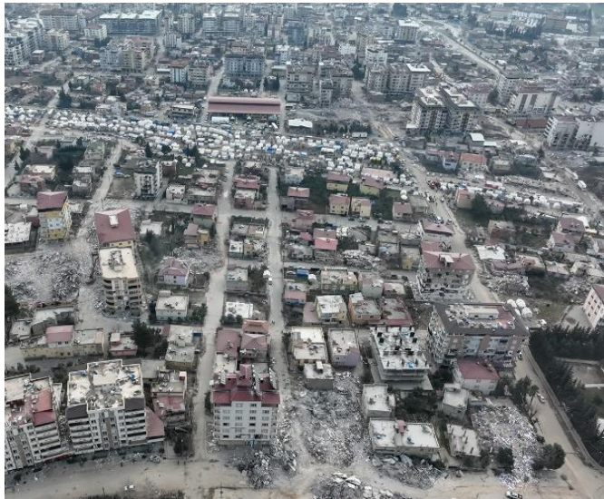
Figure 109. Quartier fortement endommagé à Nurdağı (Gaziantep) après le séisme. @AnadoluStaff
