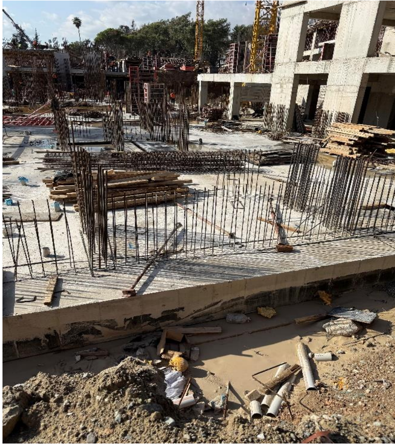
Figure 49. Chantier de reconstruction à Hatay : fondations en béton armé. Système de fondation en cours d'exécution, associant un radier à un ferrailage dense de poteaux et voiles en attente, illustrant l'application de principes parasismiques dans la reconstruction. @SemihMentese
