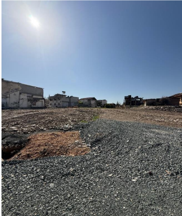
Figure 57. Parcelle nivelée issue des destructions post-sismiques à Antakya. Espace dégagé résultant des démolitions, témoignant de la disparition du tissu urbain préexistant et de la préparation à de futures opérations de reconstruction.
