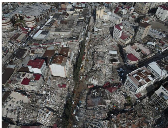
Figure 22. Vue aérienne des destructions massives du tissu urbain à Kahramanmaraş après le séisme du 6 février 2023, illustrant l'ampleur des effondrements structurels. @Reuters
