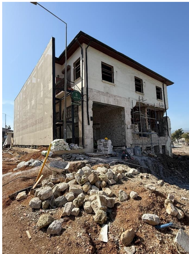
Figure 70. Chantier de restauration : tri et stockage des pierres d'origine, Antakya. @SemihMentese
