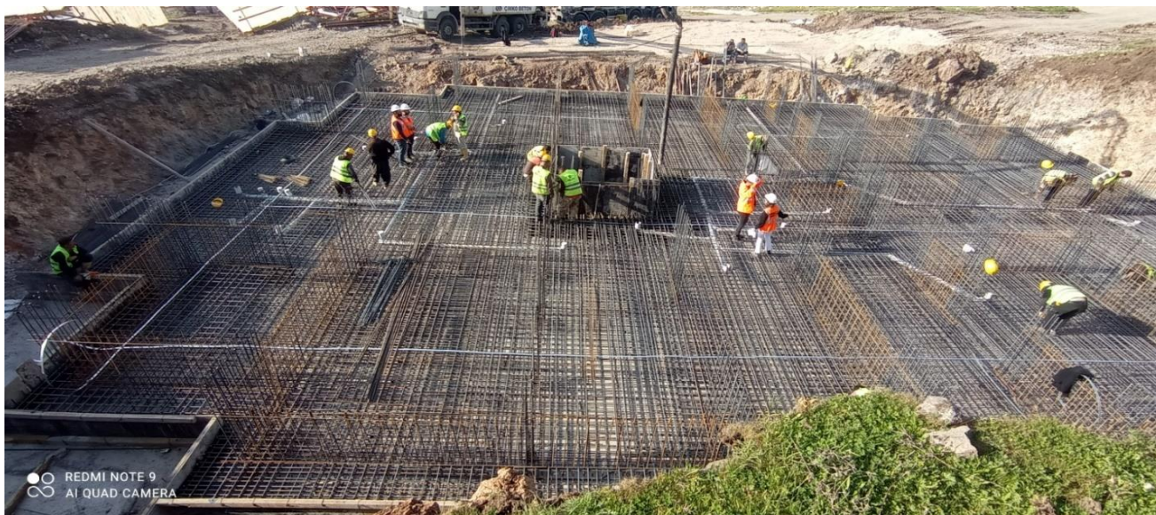
Figure 97. Phase de construction des fondations de TOKI à Kahramanmaraş, illustrant la mise en place d'un radier en béton armé fortement ferrailé, caractéristique des dispositifs constructifs standardisés mis en œuvre par TOKI. @HamzaKarpuz
