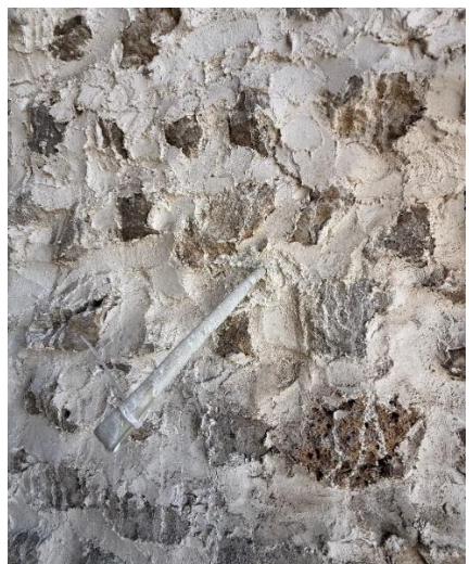
Figure 76. Injection de mortier à la chaux dans une maçonnerie ancienne. @SemihMentese
