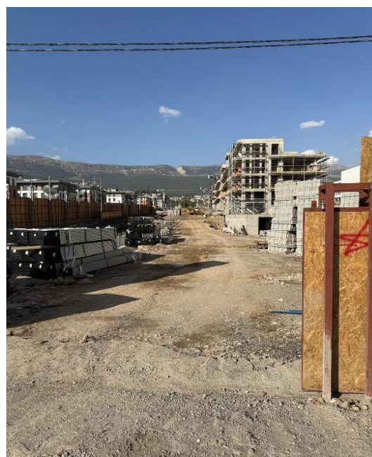
Figure 91. Développement de grands ensembles résidentiels par TOKİ à Kahramanmaraş, montrant l'ampleur des opérations de reconstruction et l'urbanisation en cours. @SemihMentese
