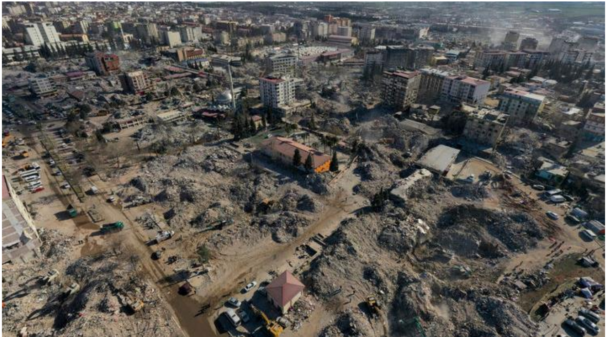
Figure 92. Vue aérienne de Kahramanmaraş après le séisme du 6 février 2023, montrant l'ampleur des destructions et la fragmentation du tissu urbain. @SemihMentese
