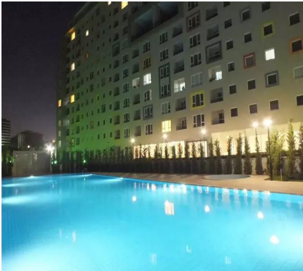
Figure 24. Le Rönensans Rezidans, construit en 2012 par Antis Yapı, était présenté comme conforme au règlement parasismique avant son effondrement lors du séisme. @DünyaGazetesi.
