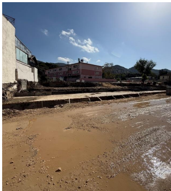
Figure 56. Chaussée dégradée dans un contexte post-sismique, illustrant une hiérarchisation des priorités où la reconstruction du bâti précède le rétablissement du fonctionnement urbain. @SemihMentese
