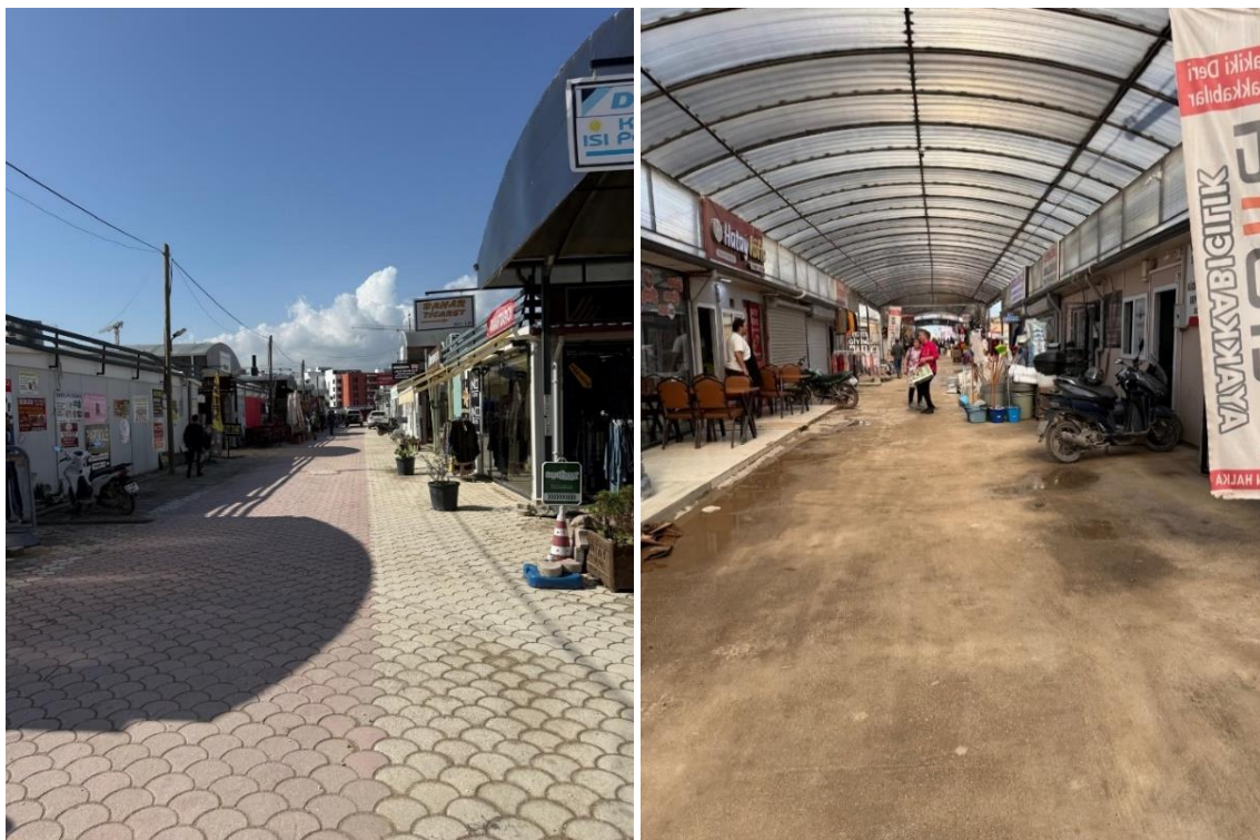
Figure 54 et 55. Marché en conteneurs structurant une urbanité transitoire, témoignant du déplacement et de la recomposition des fonctions commerciales après le séisme. @SemihMentese
