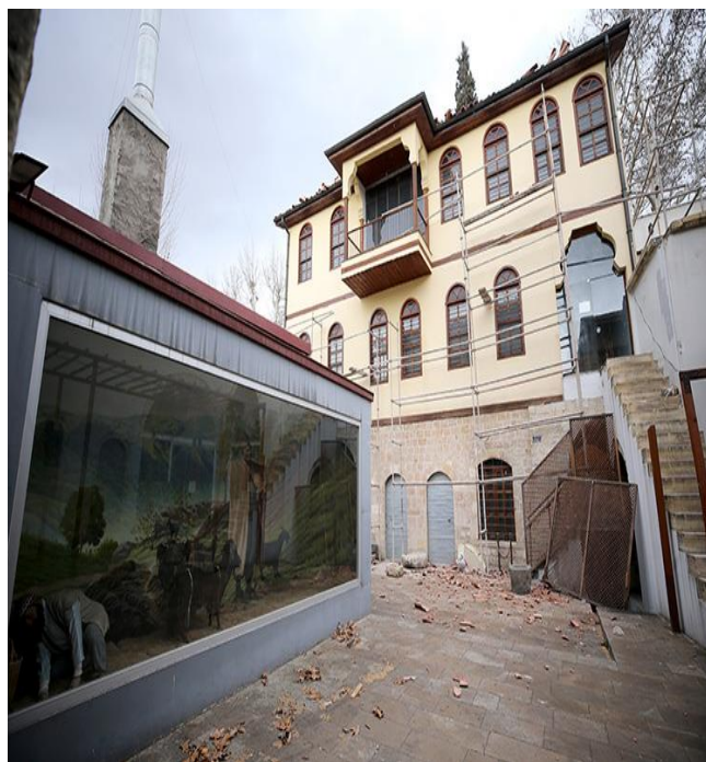
Figure 102. Katip Han Konağı (musée de la glace – Dondurma Müzesi) à Kahramanmaraş en cours de restauration après le séisme du 6 février 2023. @MehmetÖzbey
