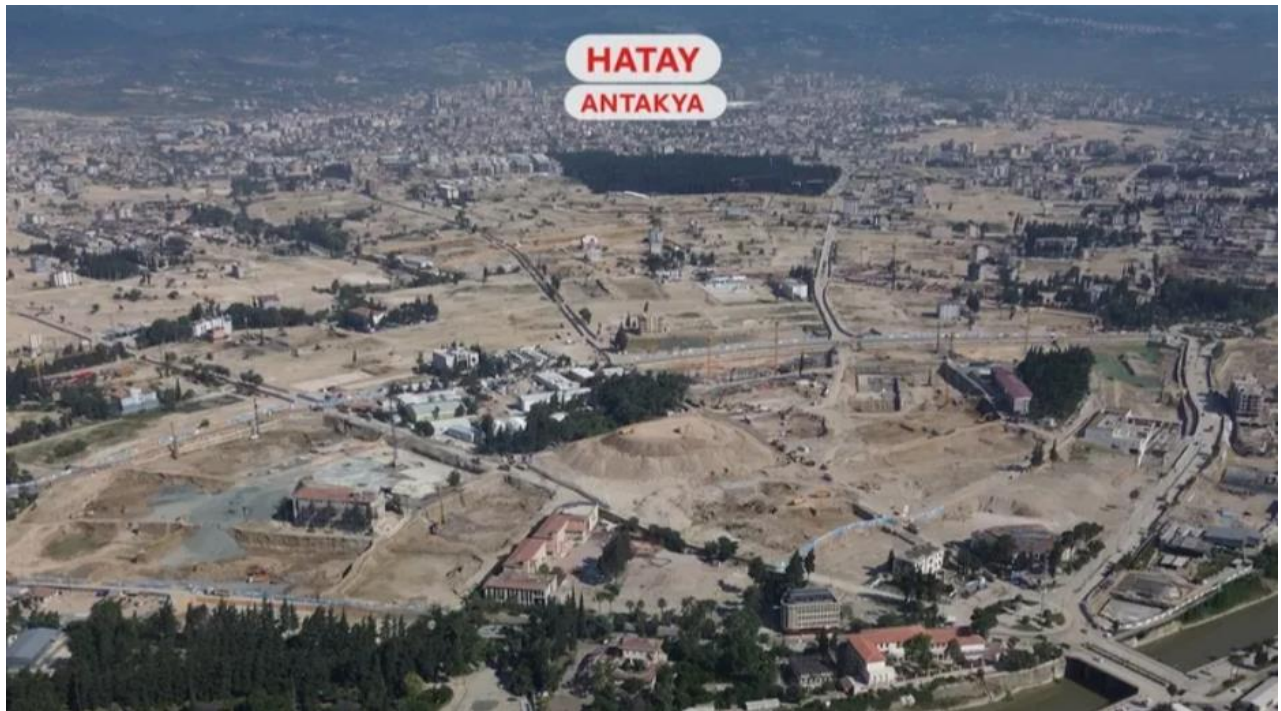
Figure 86. Vue aérienne d'Antakya après le séisme du 6 février 2023, montrant l'étendue des destructions et la disparition du tissu urbain. @Sabah
