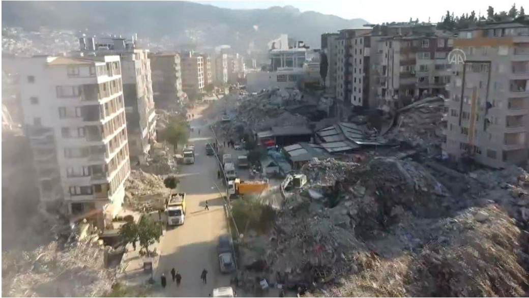
Figure 33. Destructiions massives le long de l'avenue Atatürk à Antakya après le séisme du 6 février 2023, marquant la rupture du tissu urbain. @Ministère de l'Intérieur de la République de Turquie
