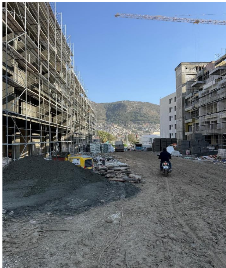
Figure 64. Quartier de reconstruction rapide in situ à Antakya, en vis-à-vis du centre historique. Ensemble de bâtiments en cours d'élévation sur une zone préalablement détruite, caractérisé par un rythme de construction soutenu et une répétition des volumes, en contraste avec les quartiers historiques visibles en arrière-plan. @SemihMentese
