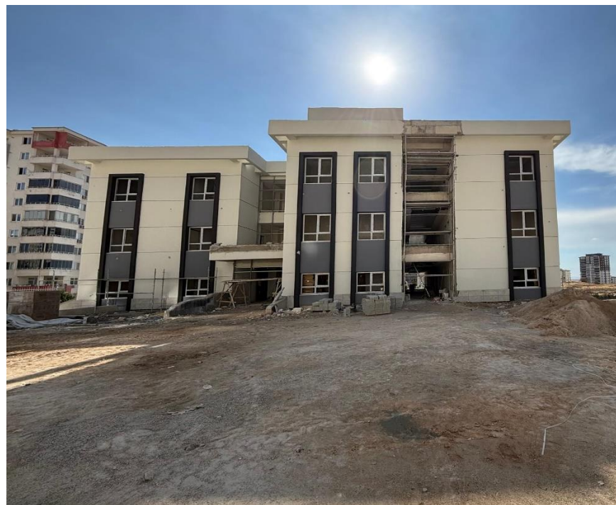
Figure 113. Hôpital Şifa en cours de construction à Gaziantep. @SemihMentese
