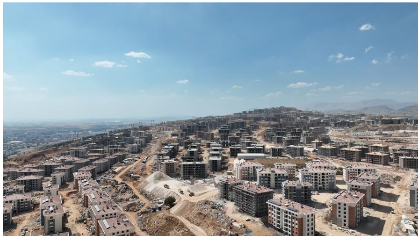
Figure 40. Vue aérienne du chantier de reconstruction à İndere (Adıyaman, Turquie), illustrant une urbanisation planifiée basée sur des blocs répétitifs, une trame viaire régulière et une organisation hiérarchisée des circulations. @T.C. Çevre, Şehircilik ve İklim Değişikliği Bakanlığı
