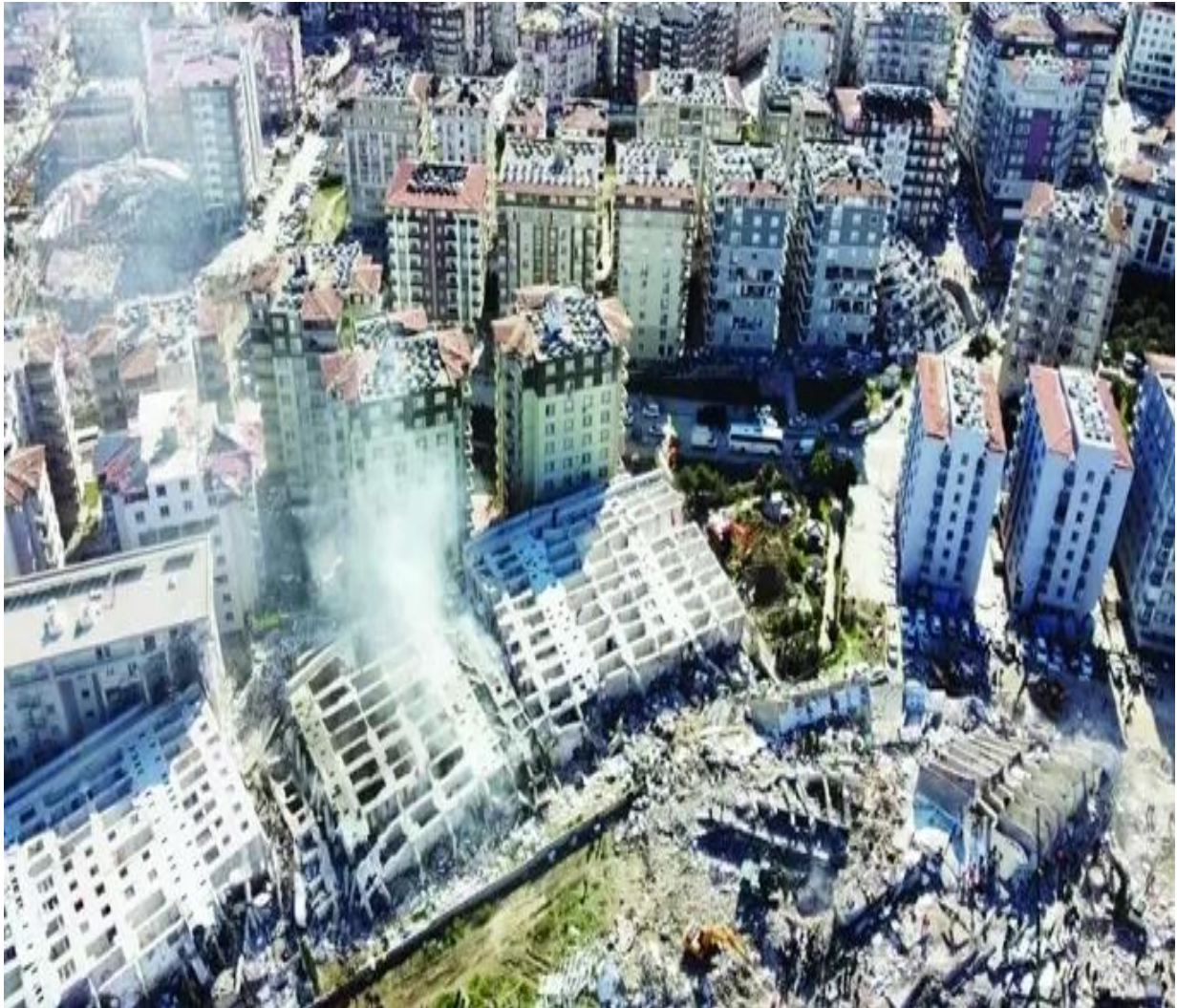
Figure 23. Effondrement du complexe résidentiel Rönesans Rezidans à Antakya lors du séisme du 6 février 2023, illustrant les défaillances structurelles et les insuffisances constructives du bâti récent. @Akşam.
