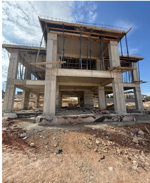
Figure 116. Maison individuelle en cours de construction à Gaziantep, projet de Yusuf Dereli. @SemihMentese
