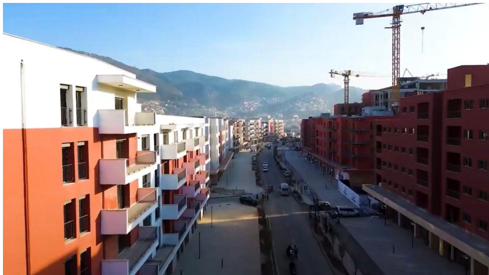
Figure 34. Avenue Atatürk à Antakya en cours de reconstruction après le séisme du 6 février 2023, révélant une recomposition urbaine fondée sur des ensembles résidentiels planifiés et standardisés. @Ministère de l'Intérieur de la République de Turquie
