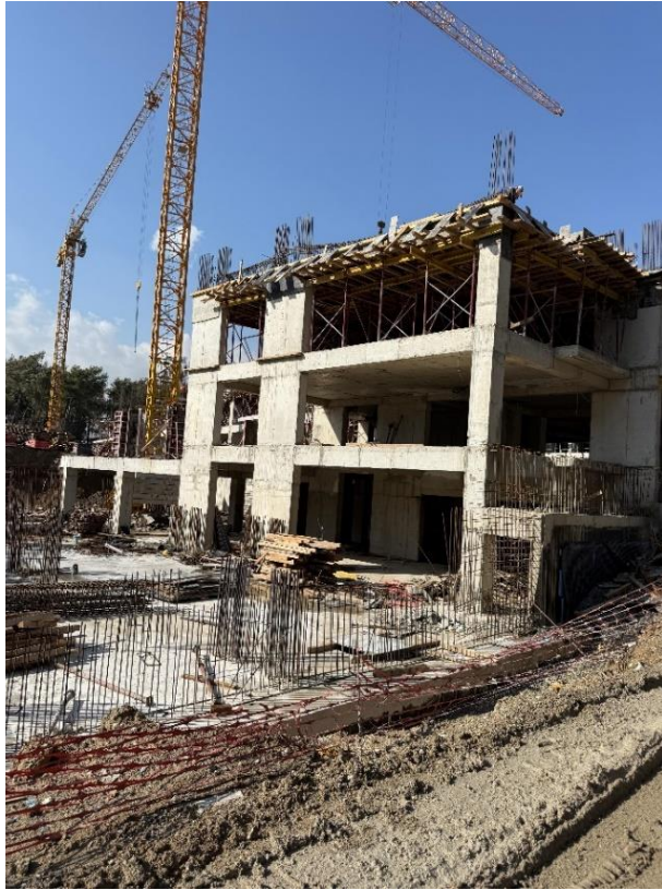
Figure 62. Chantier de reconstruction à Antakya : mise en œuvre simultanée des fondations et de la structure. Bâtiment en béton armé en cours d'élévation, illustrant l'articulation entre les dispositifs de fondation et la montée rapide de la structure dans le processus de reconstruction post-sismique. @SemihMentese
