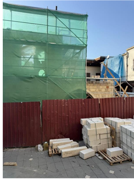
Figure 105. Mosquée Saraçhane en rénovation après le séisme à Kahramanmaraş. @SemihMentese
