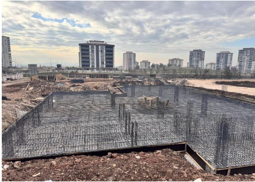
Figure 112. Hôpital Şifa en cours de construction à Gaziantep. @MahmutSevimli
