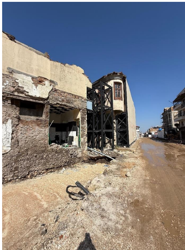
Figure 71. Chantier de restauration : étaieement de façade et consolidation provisoire, Antakya. @SemihMentese
