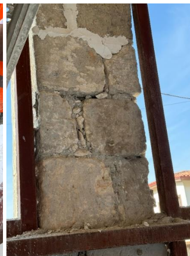
Figure 78. Maçonnerie en cours de consolidation après intervention. @SemihMentese
