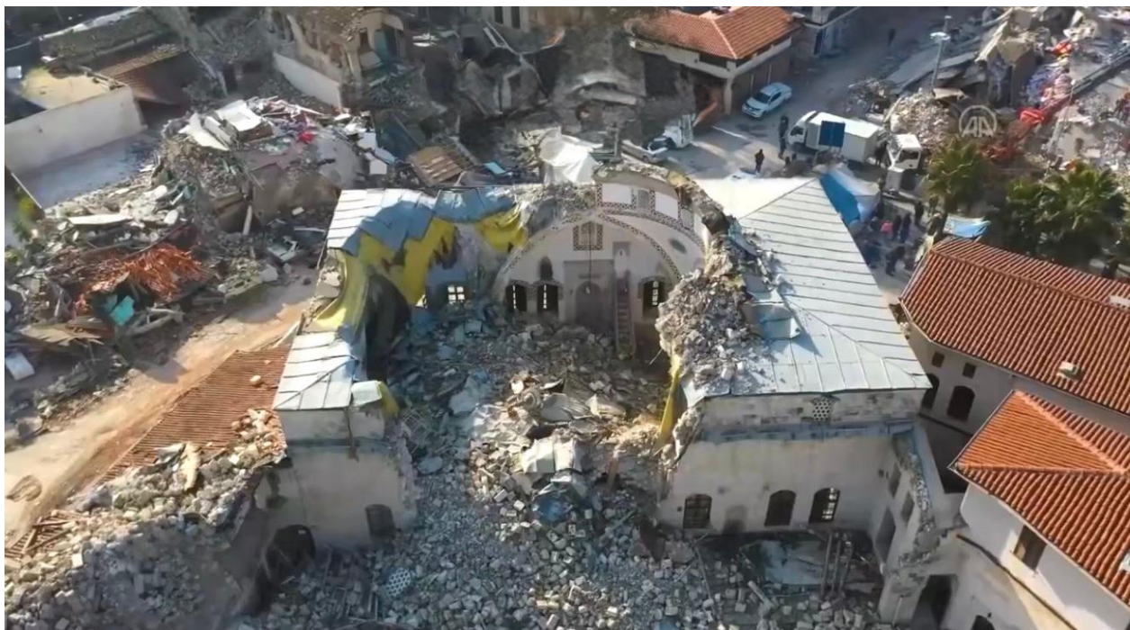
Figure 88. Mosquée Habib-i Neccar à Antakya gravement endommagée après le séisme du 6 février 2023, montrant l'effondrement partiel de la structure et l'accumulation de débris. @Sabah
