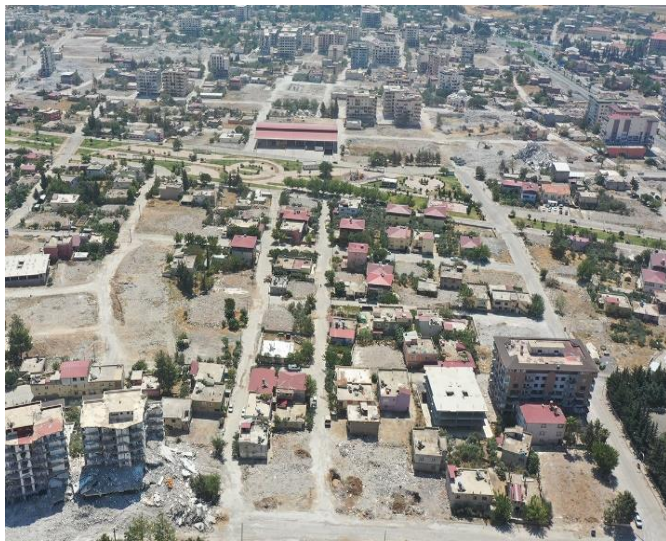
Figure 110. Quartier de Nurdağı (Gaziantep) après déblaiement des débris. @AnadoluStaff
