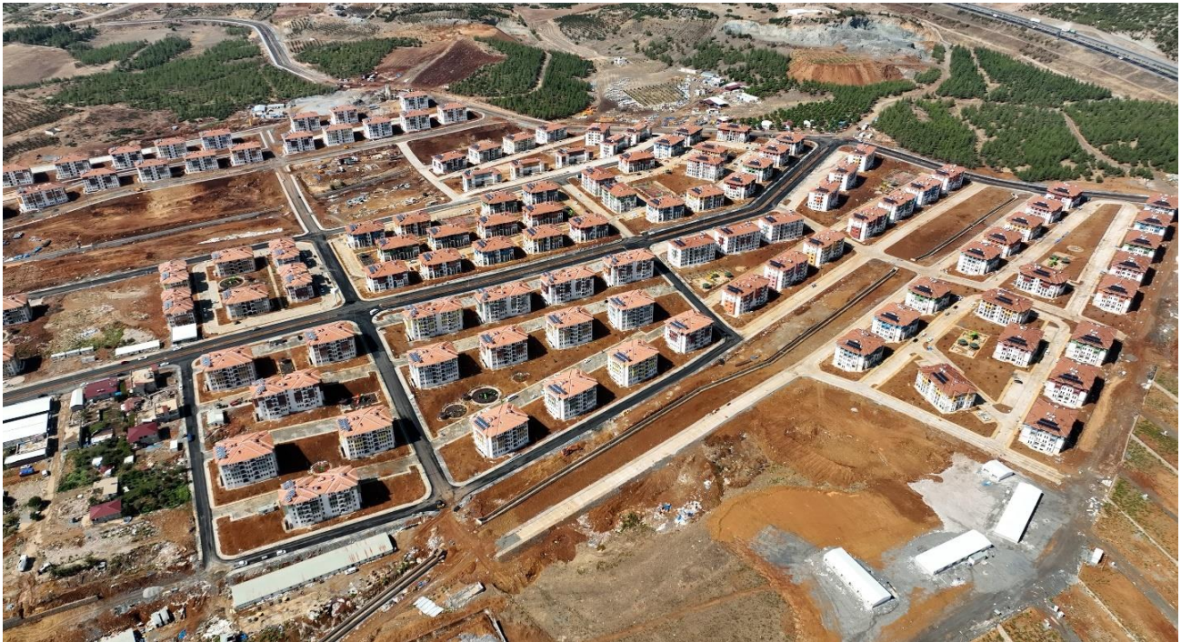
Figure 111. Quartier de logements reconstruits à Nurdağı (Gaziantep) après le séisme. @Ministère de l'Environnement, de l'Urbanisation et du Changement climatique
