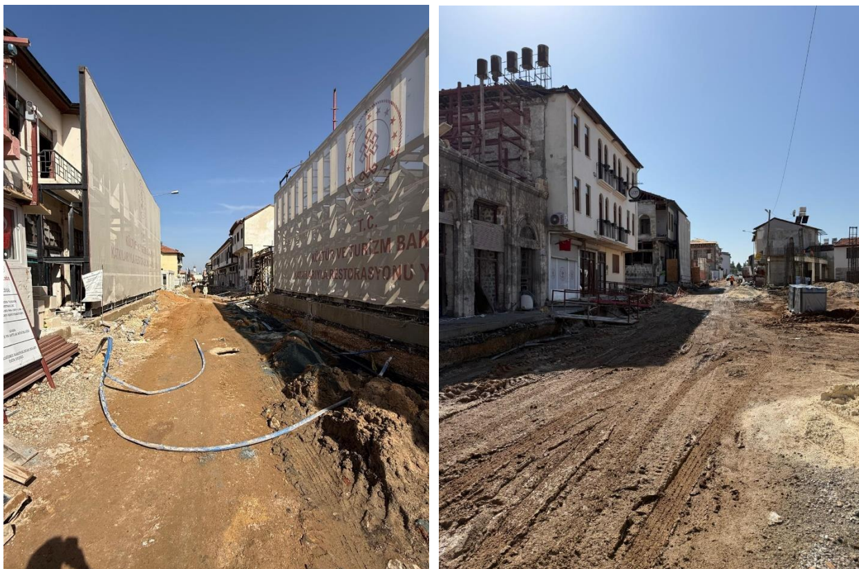
Figure 74 et 75. Kurtuluş Caddesi après le séisme : état de la rue historique en cours de réhabilitation. @SemihMentese
