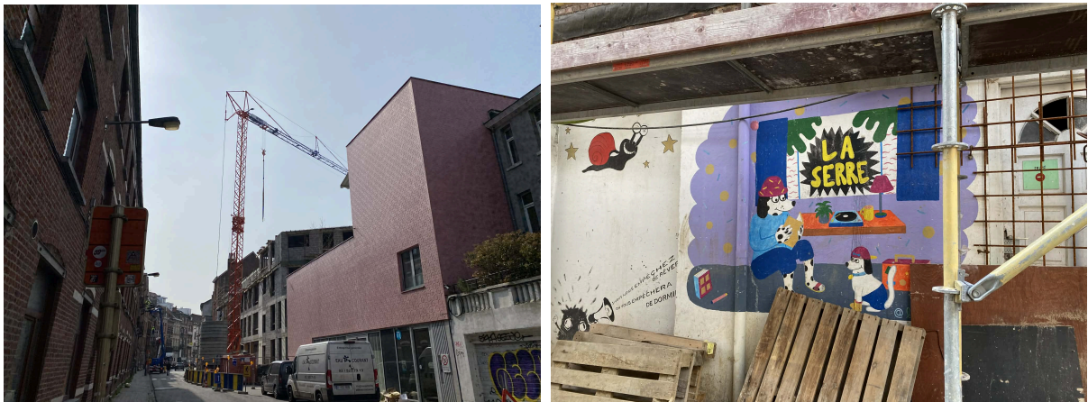
Fig.2 & 3 : Chantier rue Gray et Tag “La Serre”
