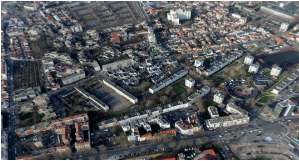
Fig. 20 : Vue aérienne du quartier "Emile-Dubois"
