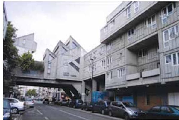
Maladrerie à Aubervilliers
