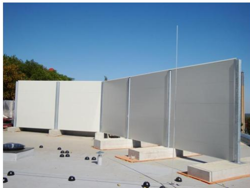
Figure 8 : Barrière antibruit installé sur un chantier afin de réduire les nuisances sonores.
