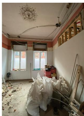
2. Comblement de l'ouverture directe vers le vestibule
