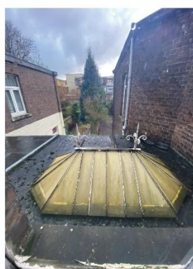
7. Vue sur le lanterneau de la véranda depuis la fenêtre de la chambre
