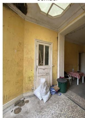
7. Accès de la véranda vers l'office
