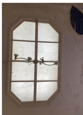
6. Lanterneau de la véranda
