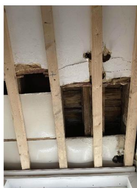
6. Nouveau faux-plafond recouvrant le plafond d'origine
