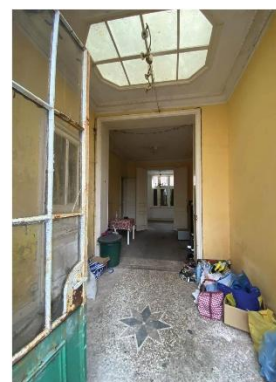
8. Accès du jardin vers la véranda
