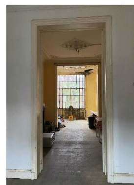
4. Accès direct du salon à la suite de l'enfilade
