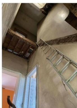
1. Escalier menant aux combles supprimé
