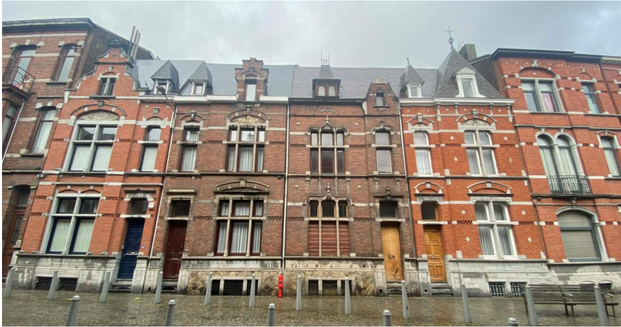
Figure 24: Ensemble de maisons bourgeoises construites simultanément par l'architecte M. Jolet, dans lequel s'inscrit le cas d'étude Source : Goffin, C.
