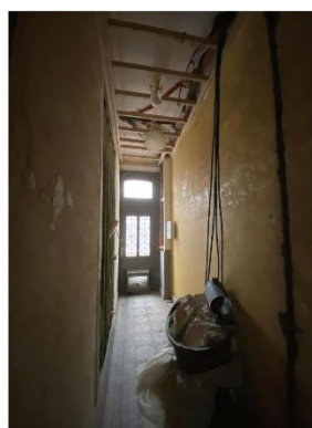
2. Travaux dans le vestibule: installation d'un faux-plafond
