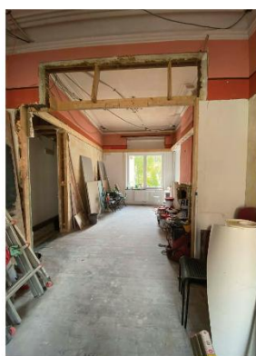
2. Différents passages donnant dans la salle à manger: du salon et du corridor
