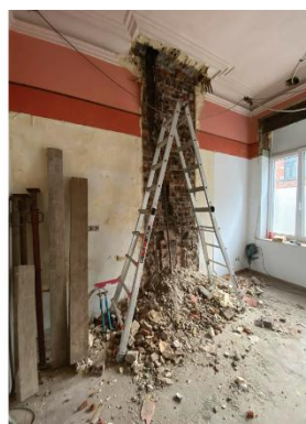
3. Démolition de la cheminée du salon
