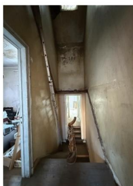
2. Palier des combles
