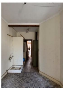
2. Accès de l'office au corridor
