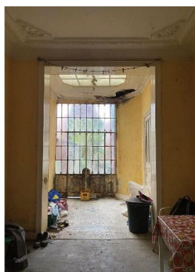
2. Accès de la salle à manger vers la véranda
