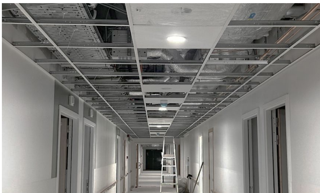
Fig. 28 – Photo de chantier de la construction de l'annexe du CH EPICURA Hornu montrant la densité technique – Aurian Joachim.
