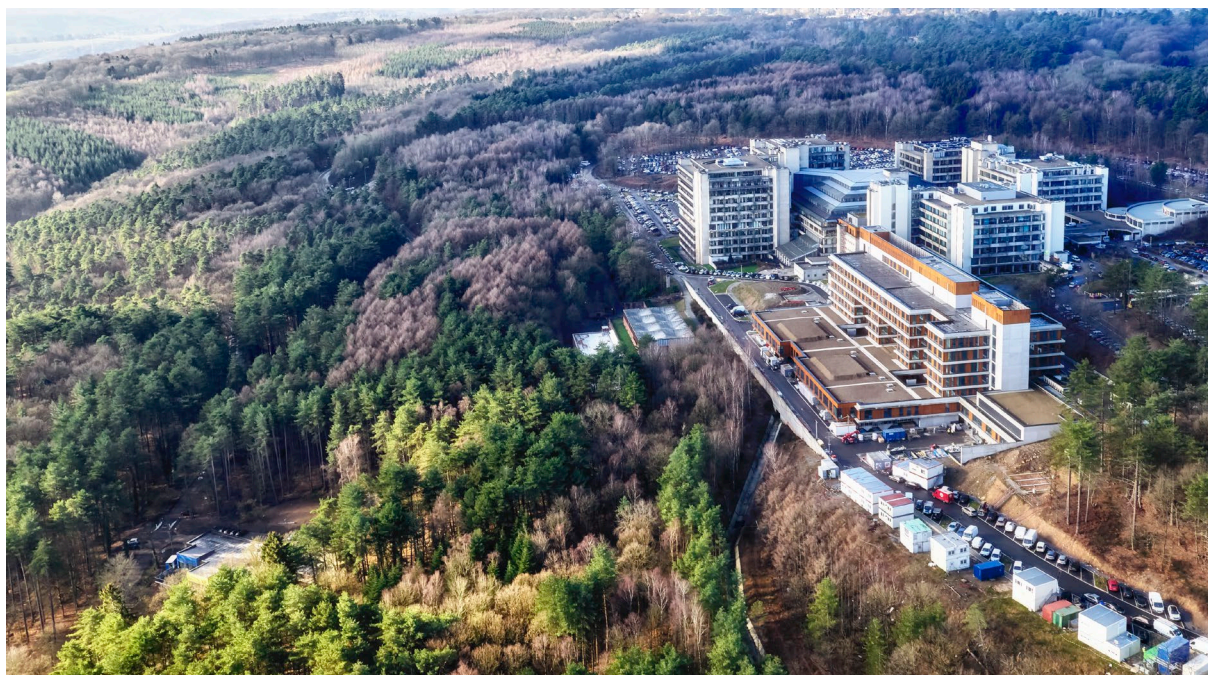
Fig. 53 – Photographie aérienne du CHU Sart-Tilman et son ancrage dans la vallée – Drone CHU.
