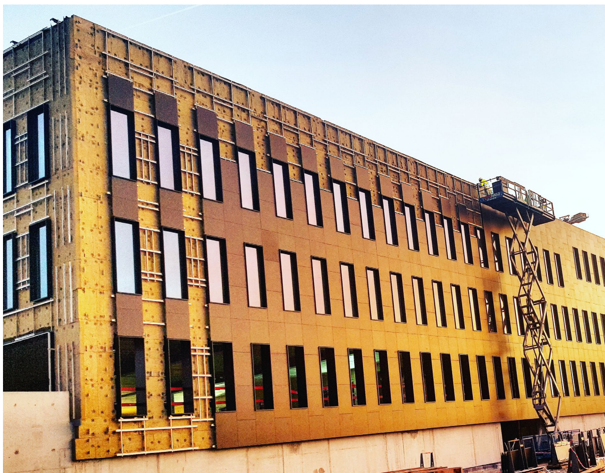
Fig. 64 – Photo de chantier du CHC MontLégia montrant le système constructif mis en place de façade démontable avec céramique sur isolant englobant la structure porteuse en béton – Groupe CHC.
