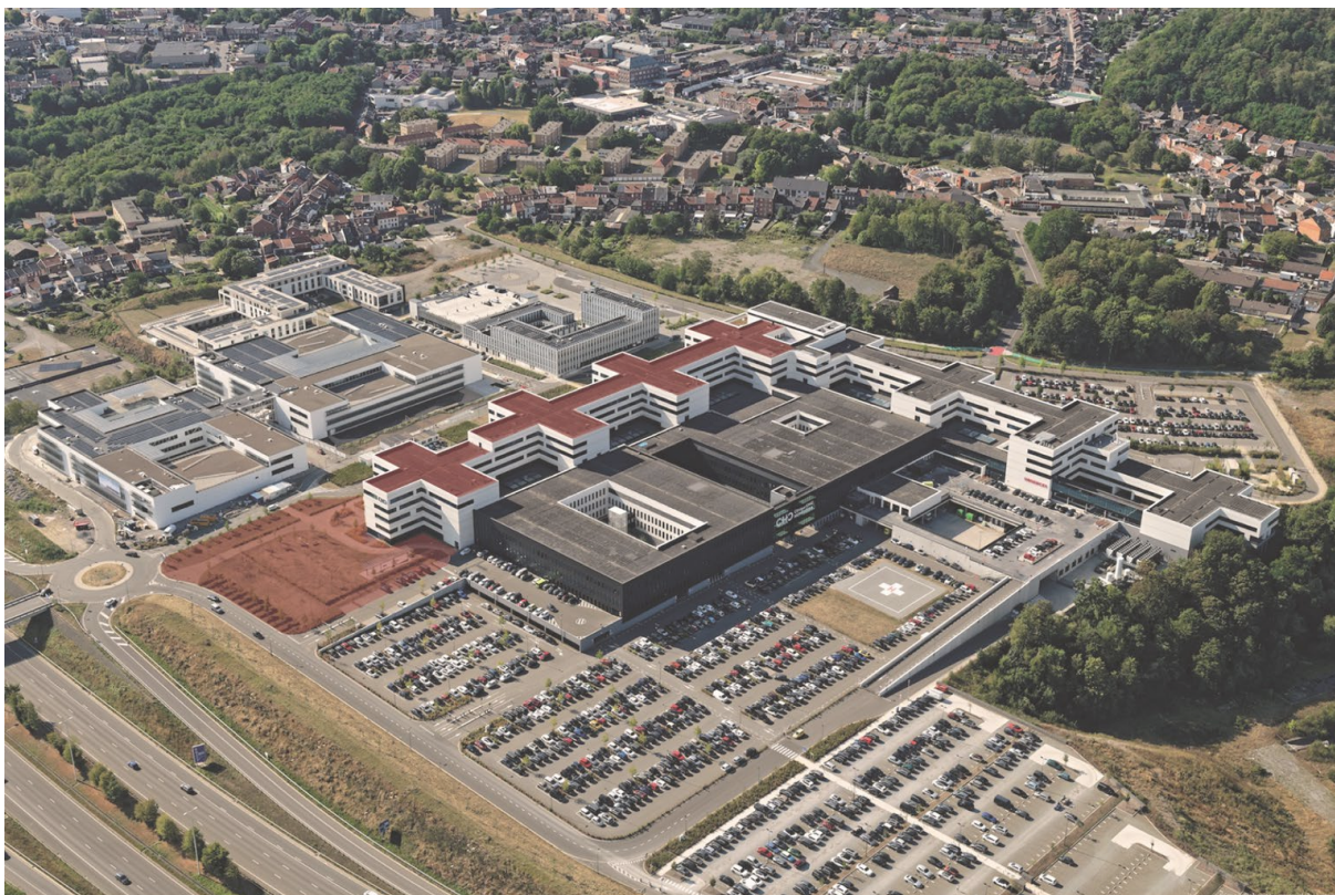
Fig. 75 – Vue aérienne du CHC MontLégia mettant en évidence les possibilités d'évolution et d'extension horizontale et verticale, comprenant rehausse de niveaux existants et surface latérale pour une nouvelle « croix » – Groupe CHC – Aurian Joachim.
