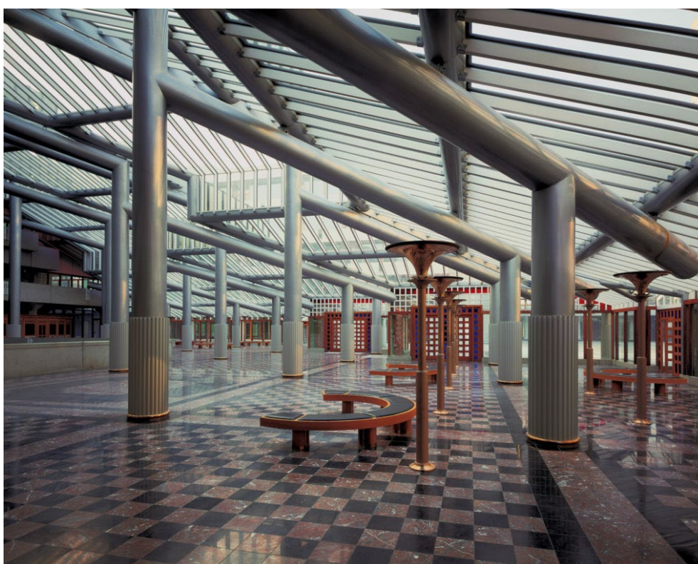
Fig. 52 – Photo intérieure de la grande verrière – Site officiel CHU Liège.
