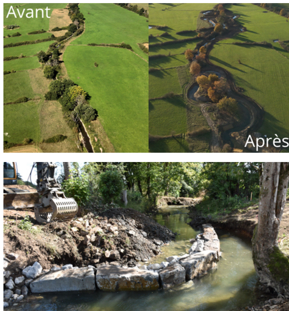
Figure 12,13,14 : photos de la reméandration de l'Eau Blanche, en province de Namur.
