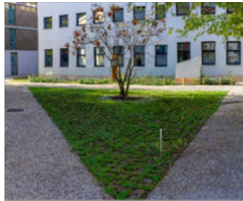
Zone pavée poreuse (permet le roulage des véhicules)
