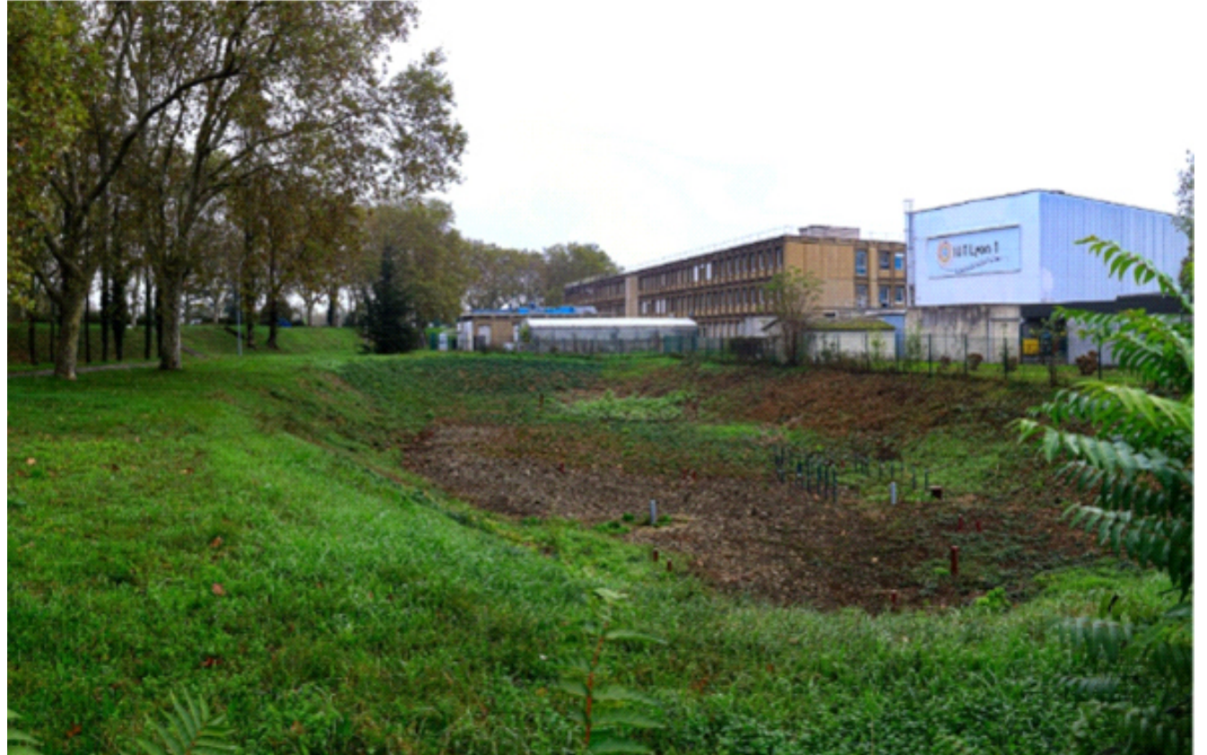
Figure 16 : Représente « le système de récupération des eaux de pluies de première génération », Campus de la Doua, photo prise par Arnaud Foret, 2024.
