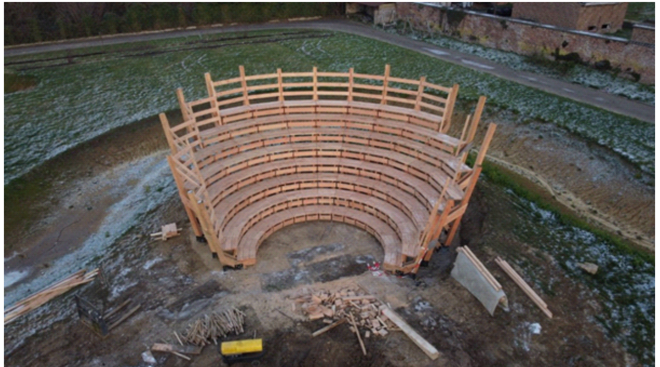
Figure 11 : photo de l'amphithéâtre en bois du jardin de pluie de Gembloux.
