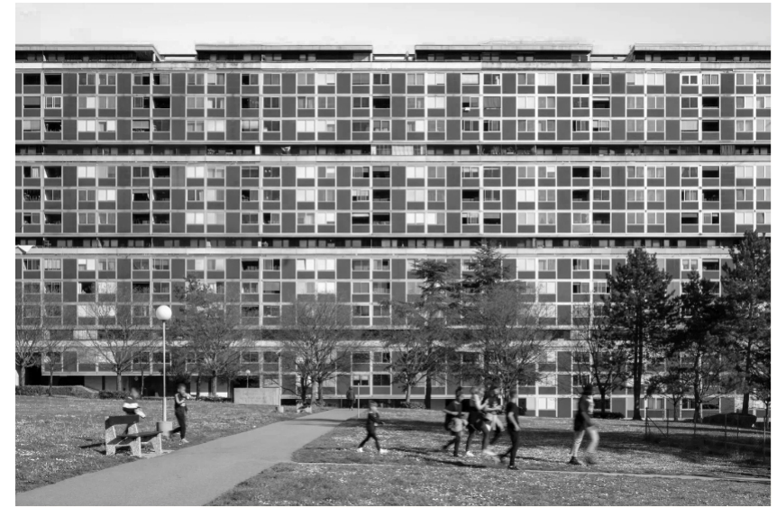
Fig 38 : Photo du Lignon depuis le parc. Source : Swiss Arc.
