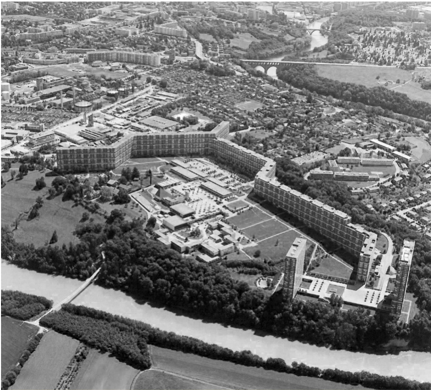
Fig 23 : Photo aérienne de la Cité du Lignon. Source : Espazium.
