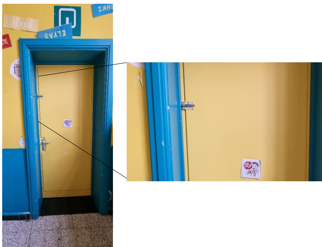
Figure 38 : Éléments mis en œuvre pour contrôler l'accès - Loquets (La Colline de l'Éveil) – (Daumalle, 2026)
