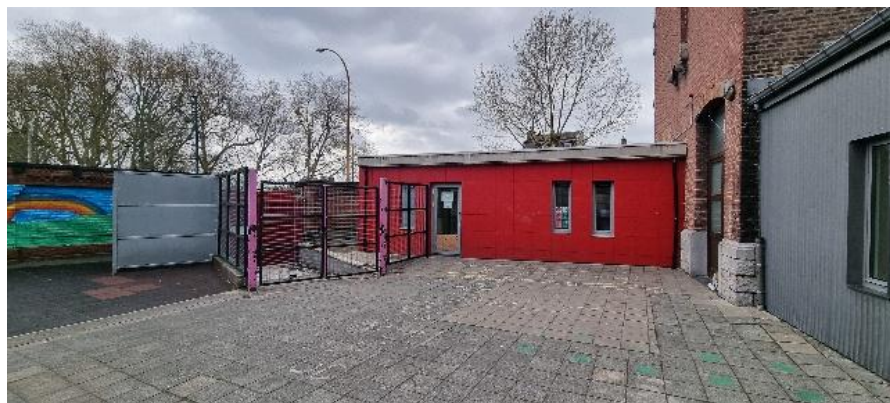
Accès vers les toilettes (bâtiment rouge), accès transports scolaires (grilles)
