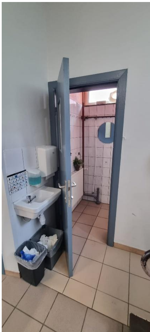
Toilettes du RDC
