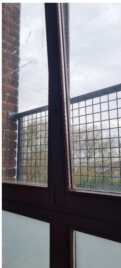
Baies sans poignées, à l'étage. Présence d'une « demie » grille en second plan/
