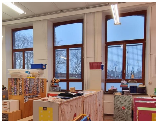
Grilles présentes derrière certaines fenêtres
