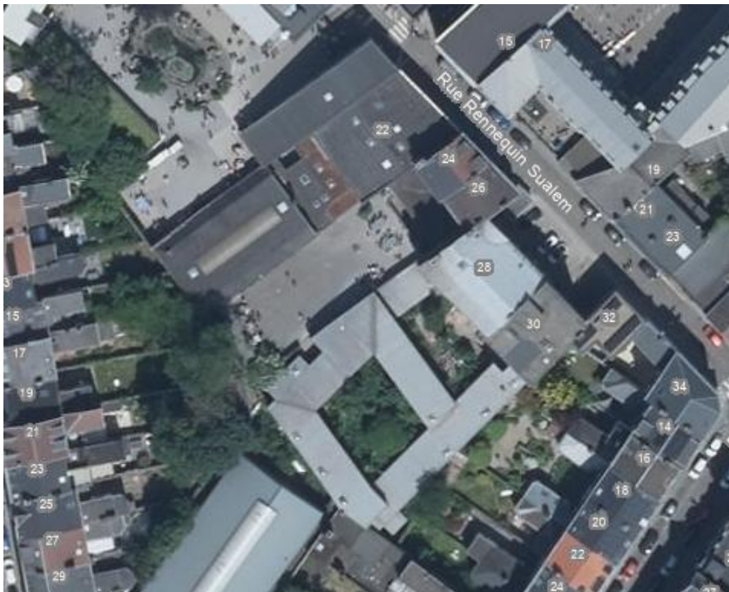
FIGURE 1 - VUE AÉRIENNE DE LA RUE RENNEQUIN SUALEM (RÉGION WALLONNE, S.D.)
