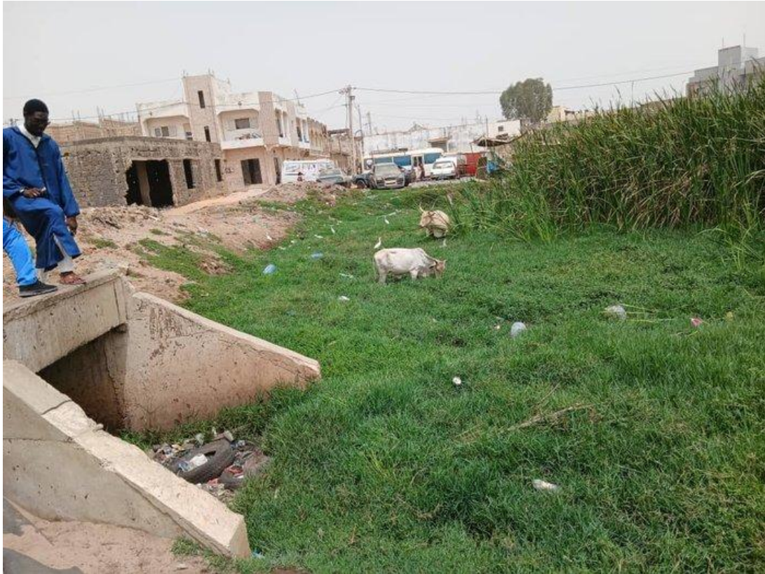
Photo 3 : Canal PROGEP envahi par le bétail et les déchets, illustrant le déficit de maintenance et l'absence d'appropriation communautaire (Cliché : DIALLO M.Y., terrain 2026 )
