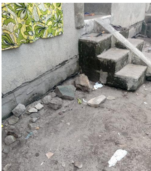
Figure 14 : Photo d'escalier d'entrée surélevé, stratégie préventive contre la montée des eaux (cliché : E. OUEDRAOGO, 2026)
