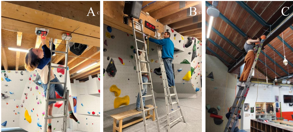
Figure 19 : Installation des instruments : (A, B) Salle A ; (C) Salle B.
