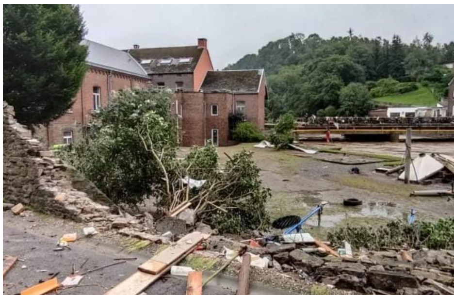
Figure 14. Dégâts causés par les inondations de juillet 2021 à Nessonvaux, (photographie prise par un riverain)
