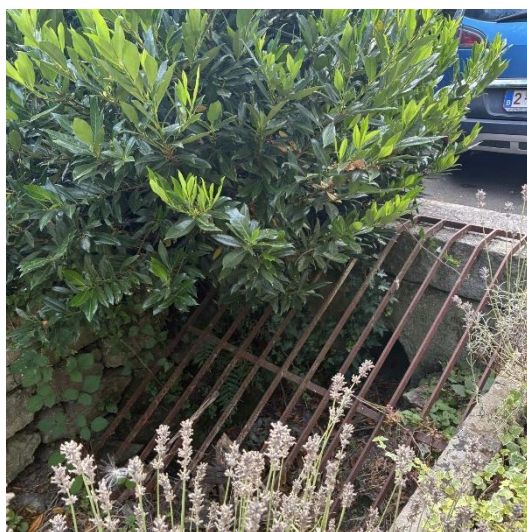
Figure 24 : Réapparition du bief à la sortie de sa partie canalisée sous la voirie (photographie personnelle prise en juin 2026)
