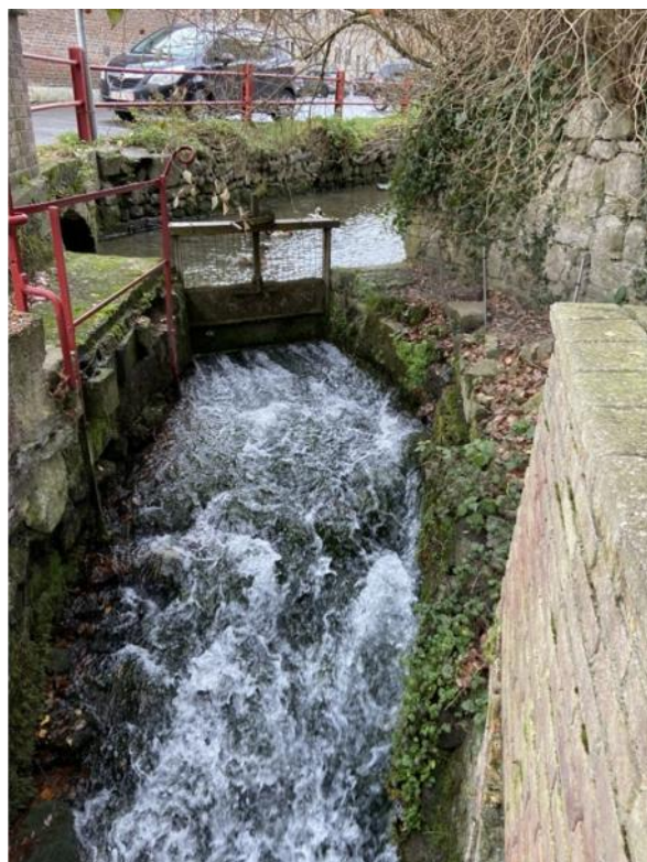
Figure 27 : Vanne du moulin du bief du Ry de Vaux (photographie personnelle prise en novembre 2025)
