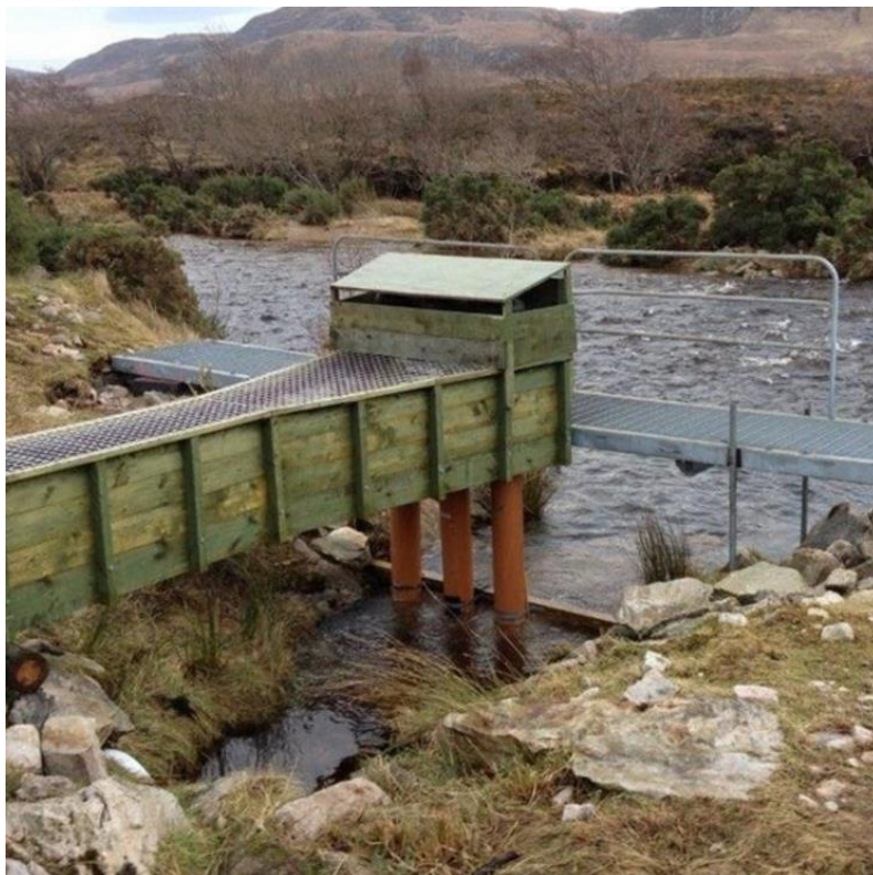
Figure 45: Ponton en bois amenant l'eau aux turbines (PowerSpout, 2017)
