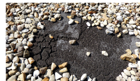
Figure 4.25 : Détail de la composition de la surface du toit de la résidence Damrémont. Photo du 11 juillet 2017 (B. Cazenave)
