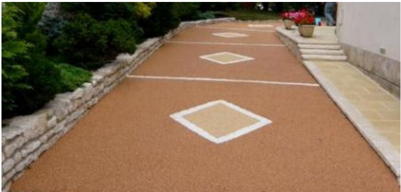
Figure 4.41: Exemple de motif de revêtement perméable (Permeaway 2016)
