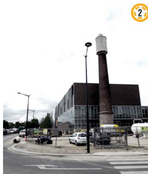
▲ Fig 23. Cheminée en brique des anciennes usines BHV Source : Thibault Verdon, Mai 2017
