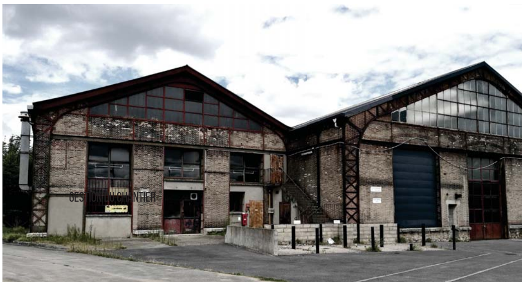
▲ Fig 75. Hangar de stockage d'Emmaüs Solidarité sur la parcelle de la friche de l'ancienne usine des eaux Source : Thibault Verdon, Juillet 2017
