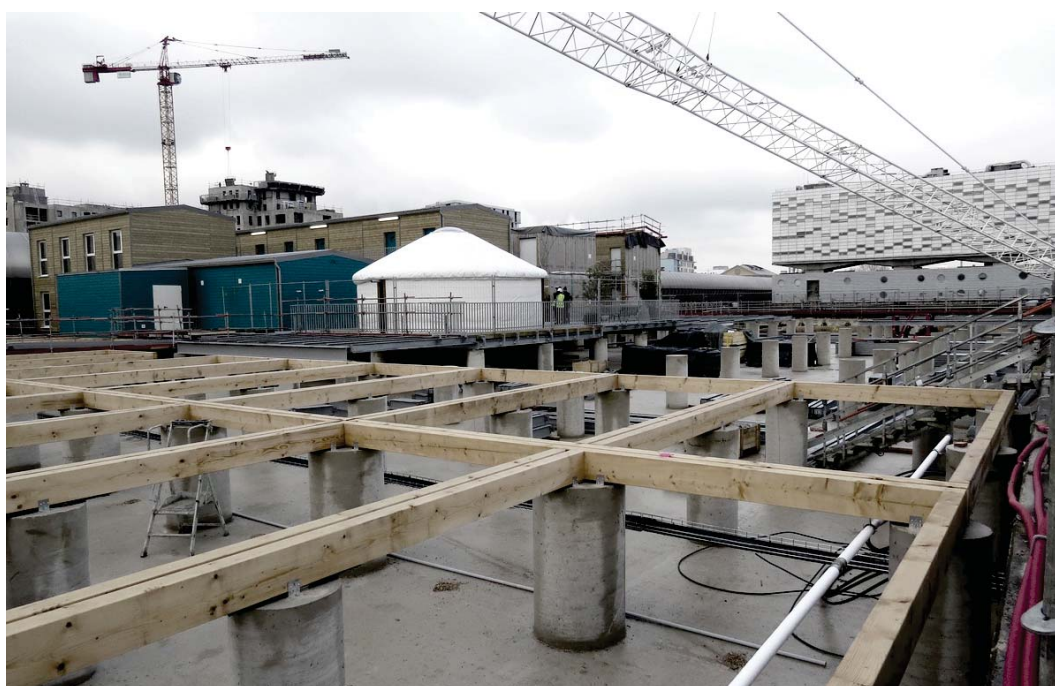
▲ Fig 41. Construction du centre d'hébergement d'urgence, vue sur les pilotis de fondations Source : R.LESCURIEUX, 2016
