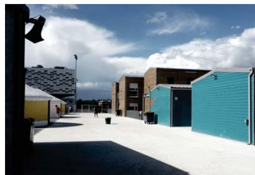
▲ Fig 38. Rue centrale du centre d'hébergement d'urgence depuis l'entrée
