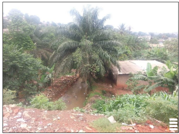
Photo 11 : Gestion locale du risque d'inondation à Elig-Edzoa par le curage des caniveaux (A) et l'élargissement du lit mineur du cours d'eau Ntem (B). Cliché : ZOGNING Olivier (Mai 2017)
