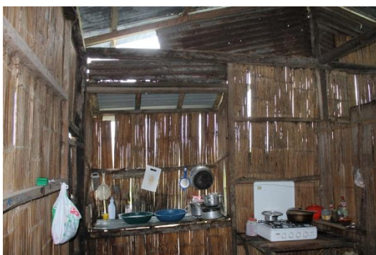
Image 6 : cuisine de la maison évaluée (Equateur), montre le passage de lumière entre les murs et de la partie haute du toit
