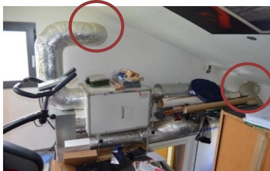
Image 31 : Système de ventilation D, conduits d'alimentation et d'extraction d'air.
