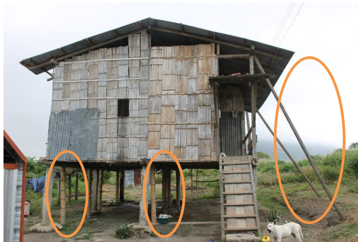
Image 29 : Vue de la maison en caña, la maison s'est inclinée de quelques degrés suite au tremblement de terre en 2016.
