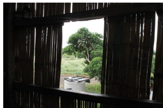
Image 5 : seule fenêtre du living, elle ne possède pas de vitrage ni de châssis.
