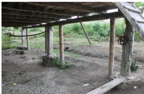
Image 14 : plancher de la maison à une élévation de 1,70m du sol
