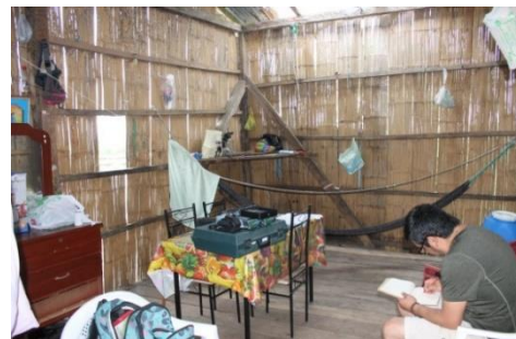
Image 13 : murs peu compacts qui permettent la ventilation naturelle
