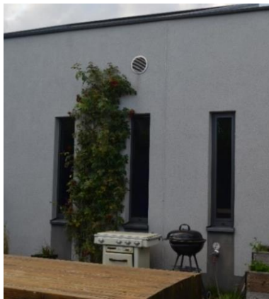
Image 33 : : ouverture de prise d'air neuf du système de ventilation -maison évaluée (Saint Vith)
