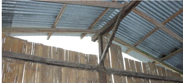
Image 7 : Ouvertures en haut des murs qui laissent passer la lumière.
