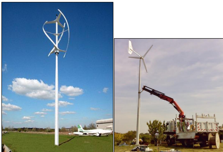
Figure 14 : Photographie d'éoliennes à axe vertical (gauche) et éolienne à axe horizontal (droite) 20
