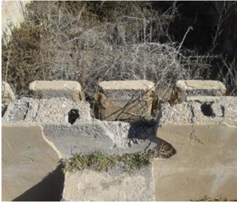
Figure 15 : Image de la dégradation du décanteur de la STEP d'El Attaouia (source : (Elan ingénierie & consulting SARL, 2016))
