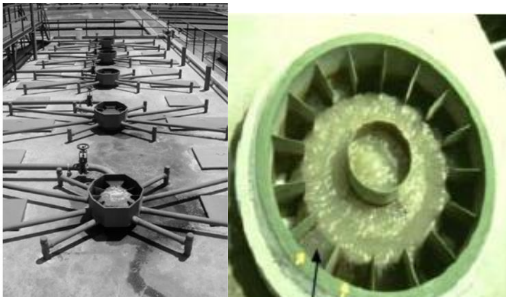
Figure 23: Répartiteurs de l'effluent pour les différents tuyaux de distributions (source : (Sperling & Lemos Chernicharo, 2005) pour l'image de gauche et (Abdelhadi, 2006) pour l'image de droite)
