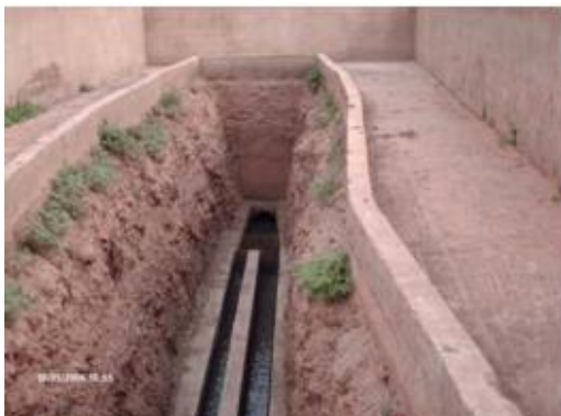
Figure 3 : Image du dessableur de la STEP d'El Attaouia en 2005 (source : (Abdelhadi, 2006))
