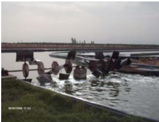
Figure 10 : Image de la roue à aubes de la STEP d'El Attaouia (source : (Abdelhadi, 2006))
