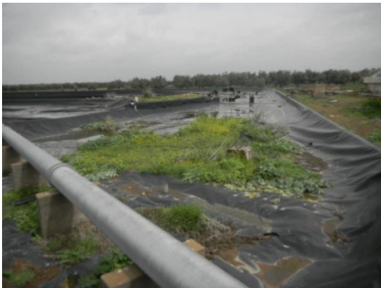
Figure 19 : Apparition de végétaux aux endroits des déchirures (2017)
