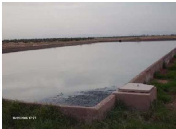
Figure 11 : Image du bassin de maturation de la STEP d'El Attaouia (source : (Abdelhadi, 2006))
