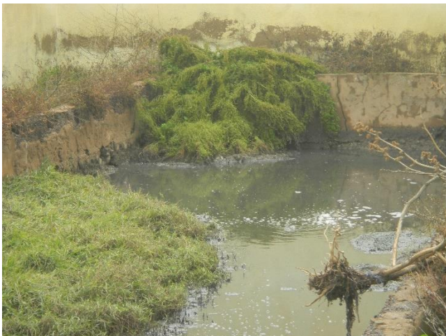
Figure 20 : Image des déchets verts dans le dessableur et bulles à la surface (2017)
