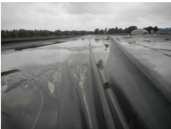
Figure 17 : Plis dans la géomembrane du CAHR (2017)
