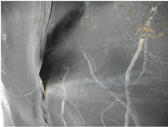
Figure 18 : Déchirures dans la géomembrane du CAHR de la STEP d'El Attaouia (2017)
