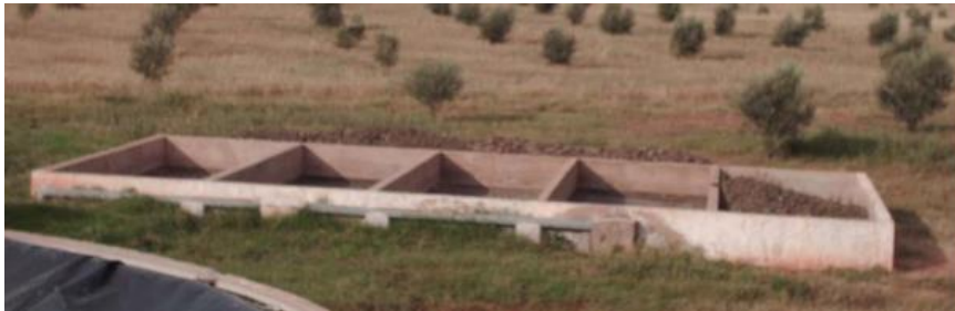
Figure 8 : Image des lits de séchage des boues de la STEP d'El Attaouia (source : (Abdelhadi, 2006))
