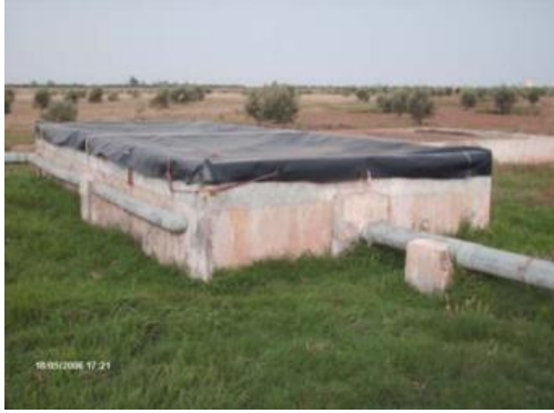
Figure 7 : Image du décanteur de la STEP d'El Attaouia (source : (Abdelhadi, 2006))
