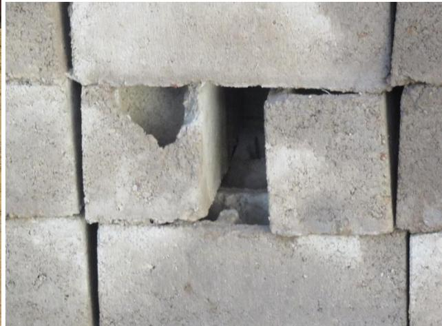
Photos 12 : Fabrication artisanale de briques en ciment, qui ne sont pas exemptes de défauts.
