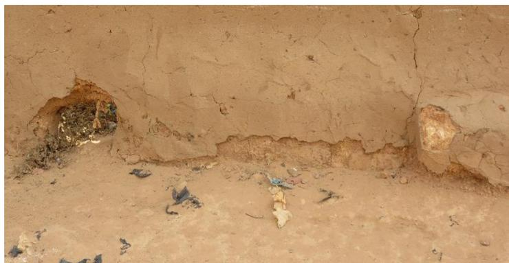
Photo 16 : Perforation à la base de la clôture. Source : Sacha Bronfort (2017)
