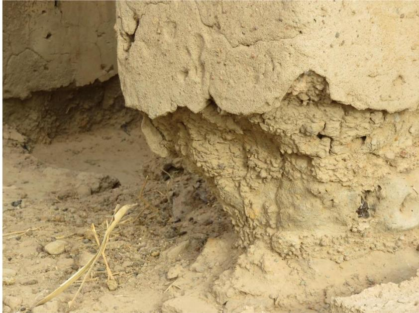
Photo 5 : Base d'un mur rongé par l'eau. Source : Sacha Bronfort (2017)
