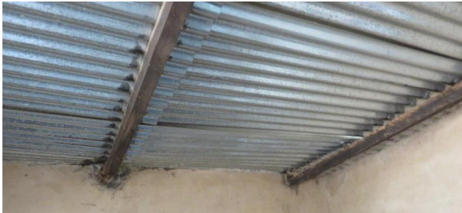
Photo 17 : Tôles neuves mais poutres moisies par l'humidité qu'il faudrait remplacer. Source : Sacha Bronfort (2017)
