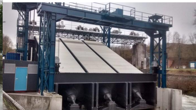
Figure 14 : centrale de Monceau abaissée
