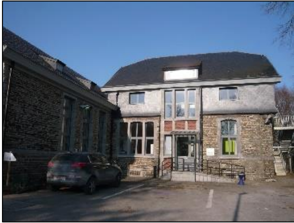
Entrée du bâtiment
