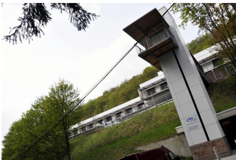
Figure 67 Mise en évidence de la forêt et de la différence de niveau par rapport à la route.
