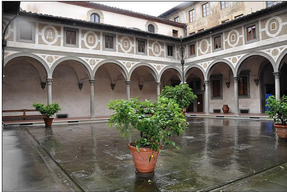
Figure 1 Cour intérieure de l'hôpital Innocenti, Florence, par Brunelleschi (1419)
