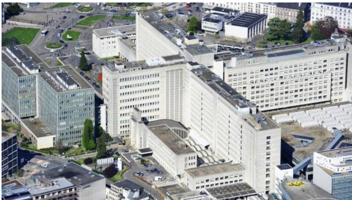
Figure 4 Vue aérienne de l'Hôtel-Dieu à Nantes
