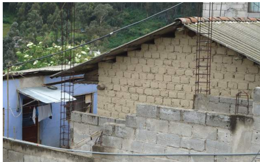
Illustration 74 – Construction en adobe
