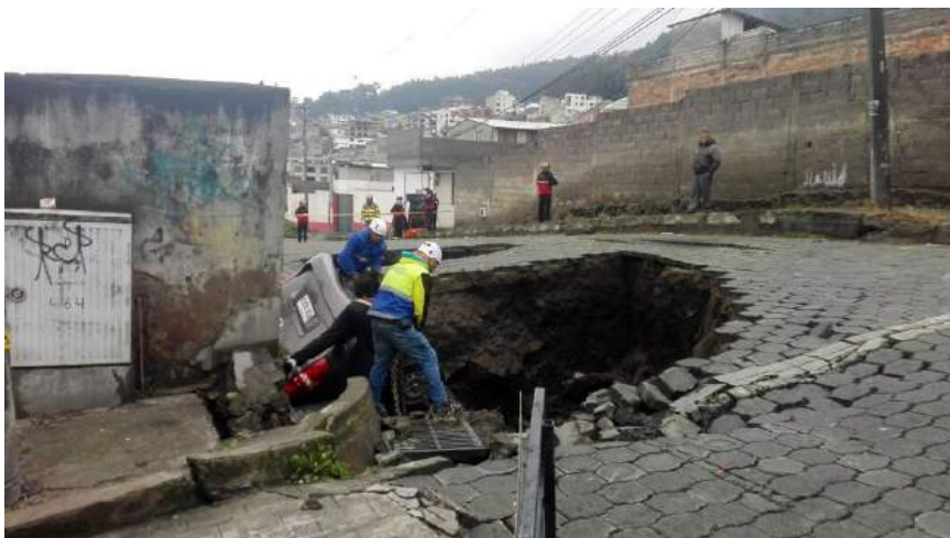
Illustration 42 – Effondrement de la rue d'Ana Maria Bajo (1)
