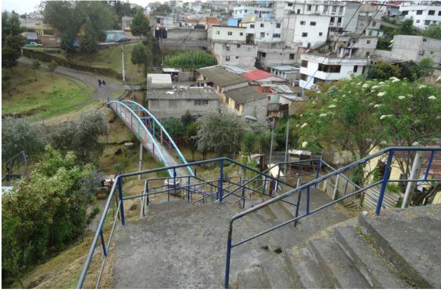
Illustration 48 – Accès viaire et piéton à la gorge
