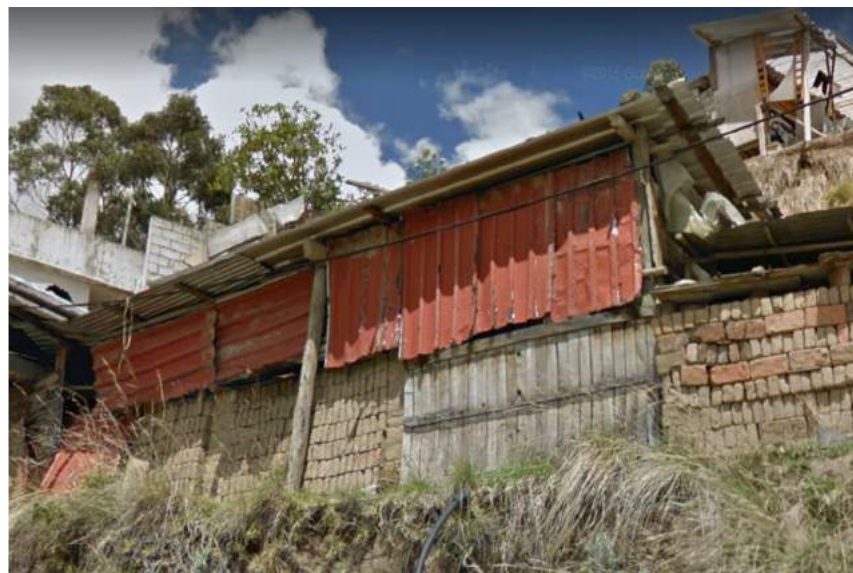
Illustration 73 – Construction en Taule métallique
