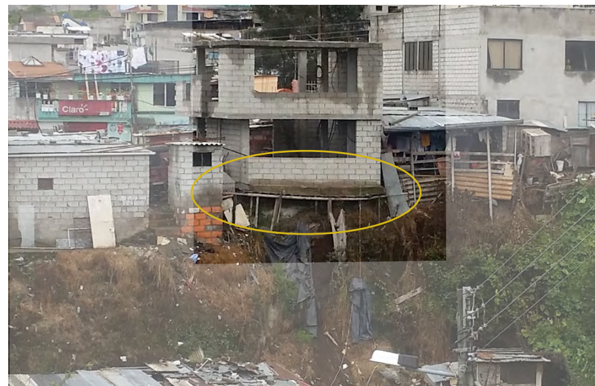
Illustration 68 – Exemple de construction spontanée et très vulnérable en bord de ravin
