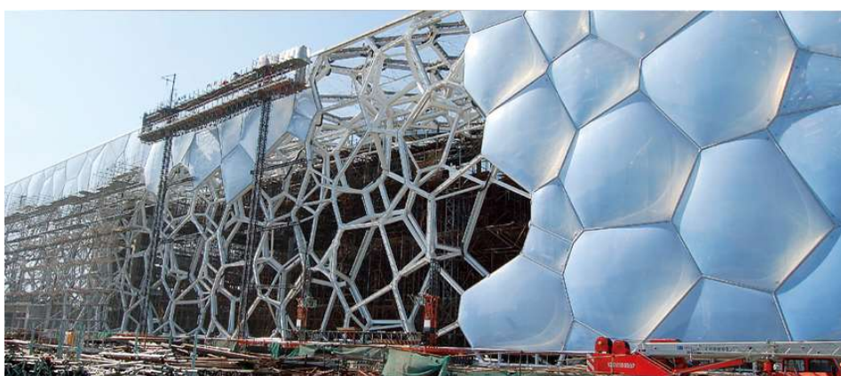
Figure 44 : Water Cube - Construction - Structure métallique et pose de revêtement (source : archdaily.com)
