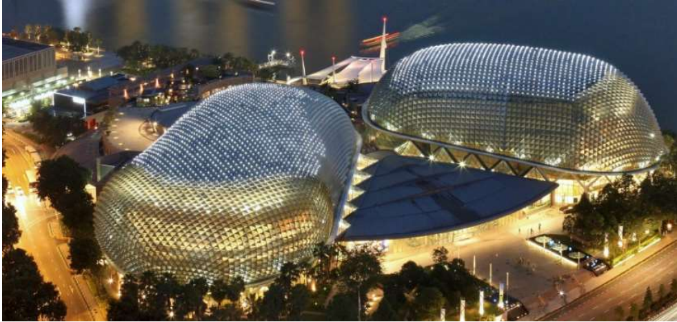
Figure 49 : Esplanade Theater - Vue extérieure – Nuit (source : archdaily.com)
