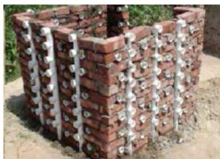
Figure 74 : Le mur respirant - prototype réalisé (gauche) - coupe de principe (droite) (EIDin & al., 2016)
