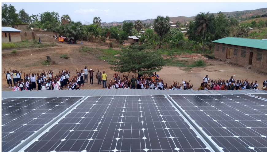
FIGURE 2 – Electrification d'une école à Boma, RDC [8]
