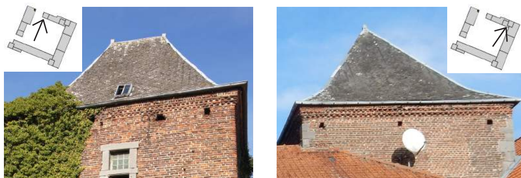
Aile nord - Côté cour - Toiture du porche et de la tour
