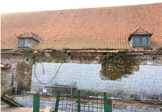
Zone en mauvais état de l'élévation côté rue de la deuxième étable
