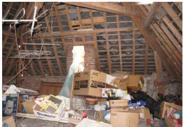
Grenier de la tour
