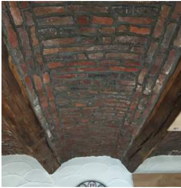
Voussette en briques dans l'ancienne petite étable
