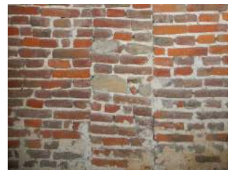
Photo à l'intérieur - Comblement de l'emplacement du pont-levis
