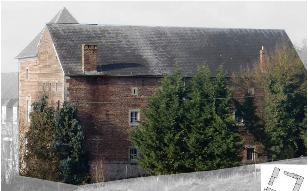
Construction sur l'aile est - Côté rue 1
