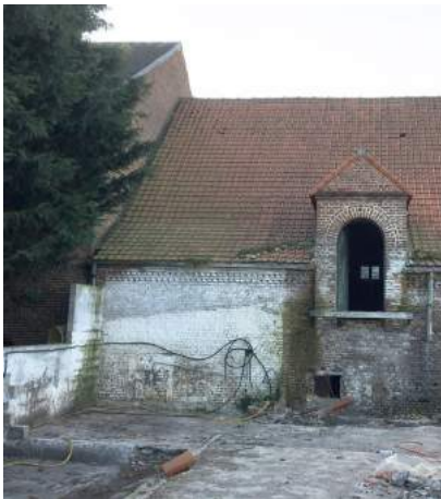
Zone en mauvais état de l'élévation côté rue de la deuxième étable
