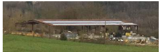
Hangar de stockage construit en 2010
