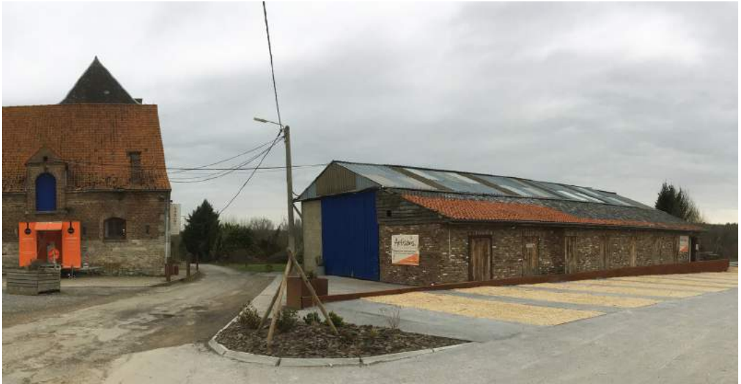
Bâtiment sur la gauche: local de transformation et magasin des Artisans de Bossimé
