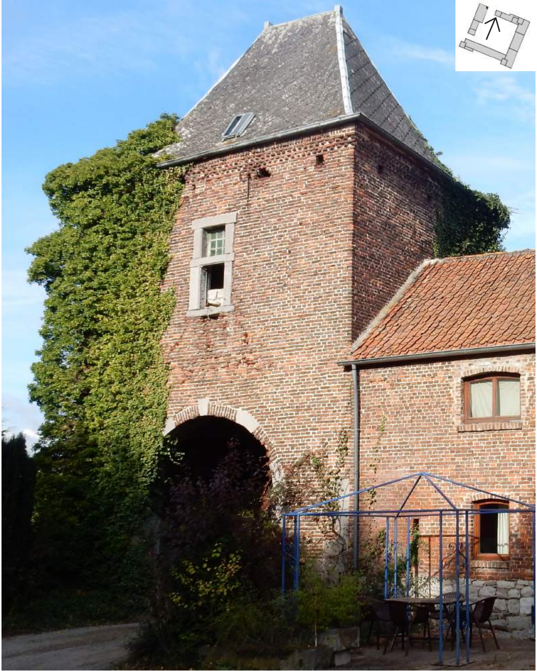
Élévation du porche côté cour
