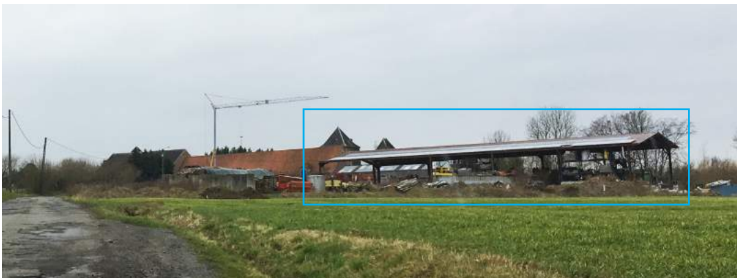
Hangar construit en 2010 depuis la troisième entrée
