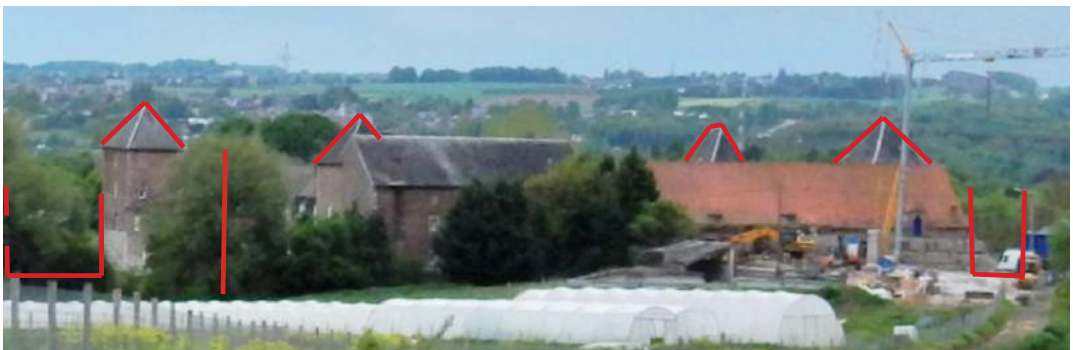
Vue vers le château-ferme - Été 2016 - Démolition du hangar agricole de 1964
