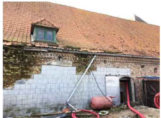
Zone en mauvais état de l'élévation côté rue de la deuxième étable
