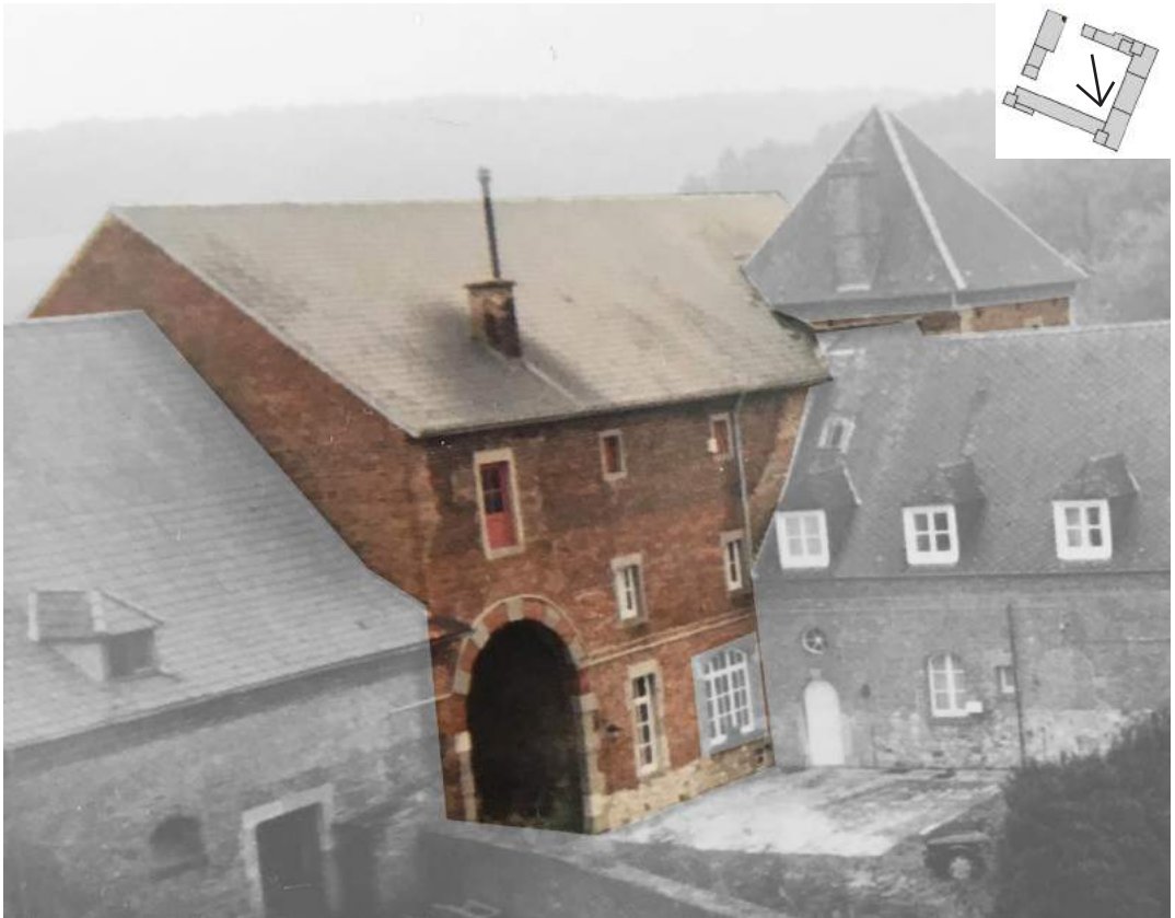
Construction sur l'aile est - Côté cour 24
