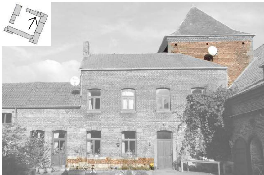
Construction sur l'aile nord - Côté cour
