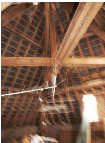
Grenier de la tour
