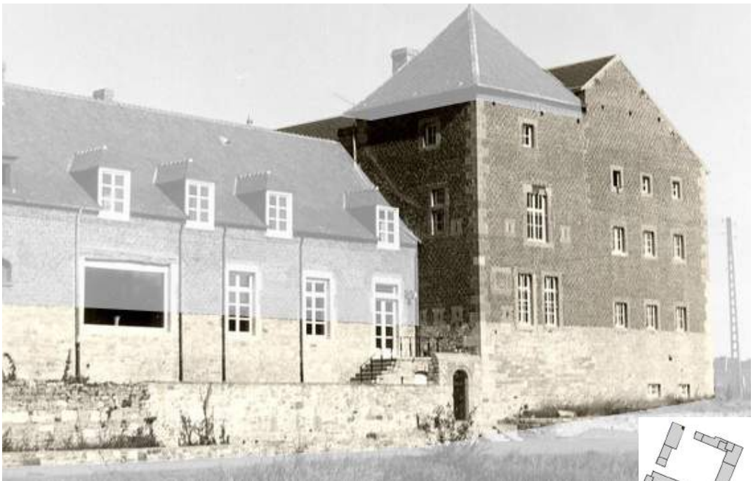
Construction sur l'aile est - Côté rue 2
