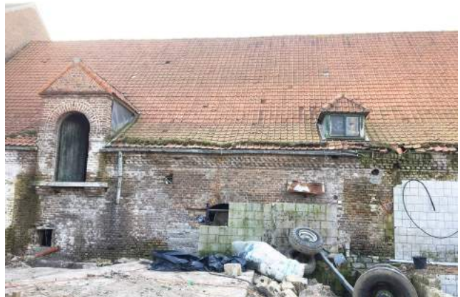
Zone en mauvais état de l'élévation côté rue de la deuxième étable
