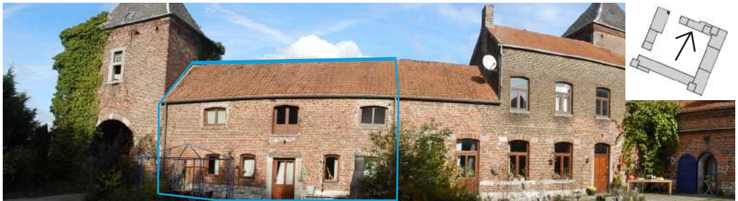
Aile nord - Côté cour - Transformation de la première étable en logement
