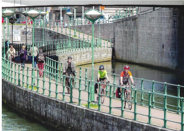
Figure 42: RAVeL trop étroit, Liège.
