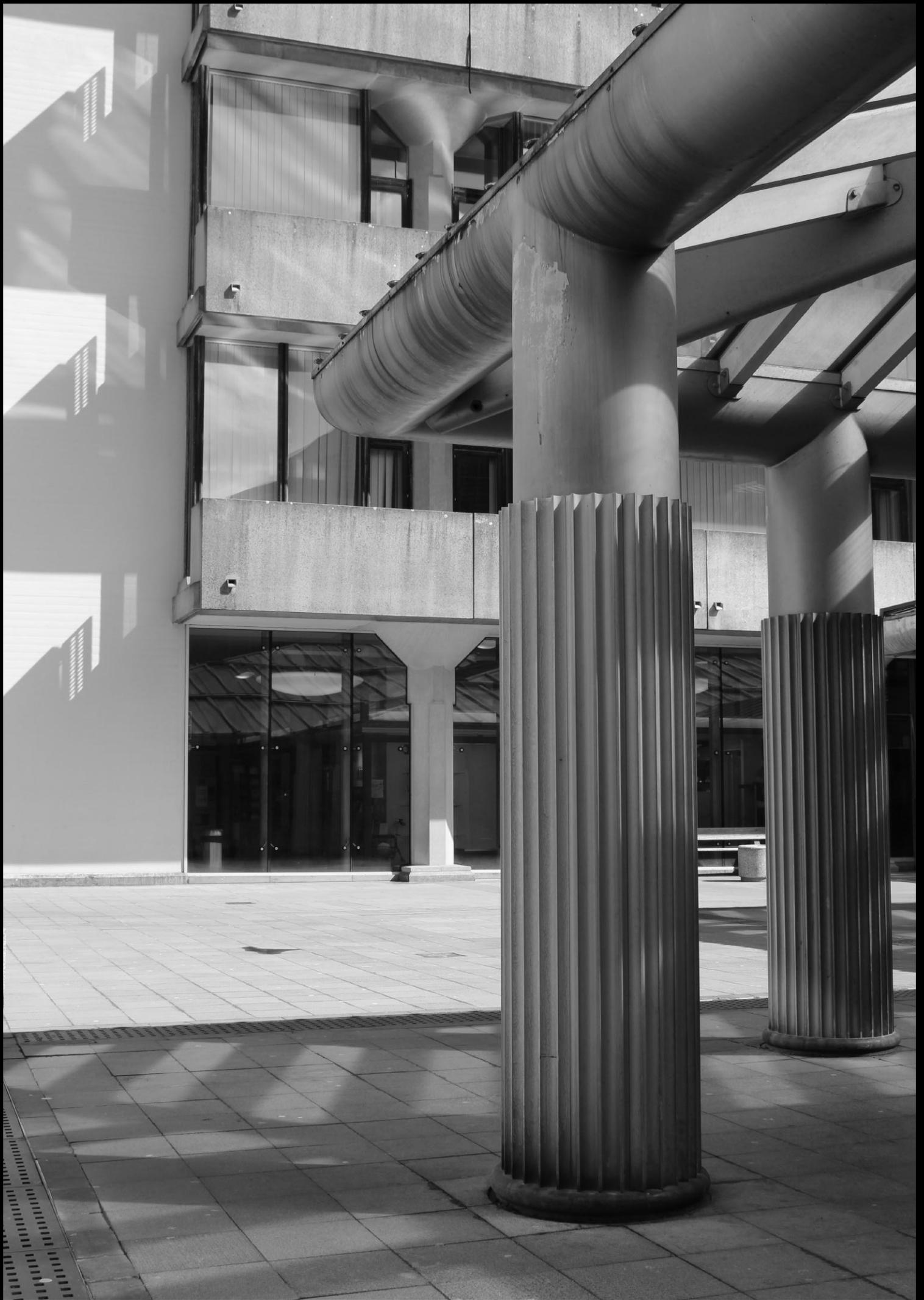
La première, élément fondateur du système constructif du complexe (fig. 50-51), est née de la nécessité de concentrer les charges provenant des poutres vers les structures verticales que sont les colonnes. Il fallait alors intégrer l'élément classique qu'est le chapiteau.<sup>289</sup>
