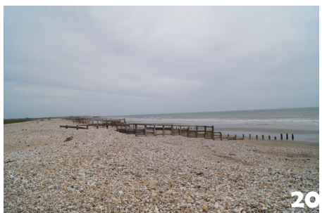
Figure III.54. Photographie de la plage et des épis en destruction devant le projet de Medmerry.
