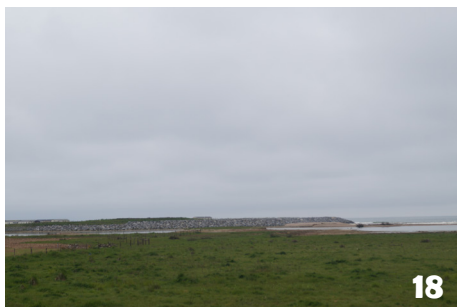
Figure III.52. Photographie des empièvements au loin depuis la berge opposée.
