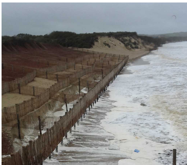
Figure I.15. La restauration de dunes comme méthode douce. Les ganivelles sont là pour aider à la reformation d'une dune à Wissant.
