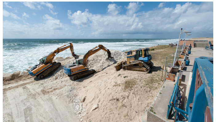
Figure I.18. Travaux de restauration des dunes sur la plage de Lacanau. Les engins utiles pour les travaux détruisent des habitats et milieux déjà en place. Source: Sébastien Ortola, 20 minutes.
