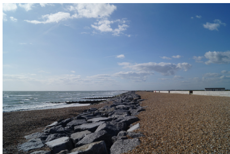
Figure III.73. Enrochement et mur de protection devant le camping Bunn Leisure.
