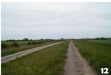
Figure III.46. Photographie depuis le haut de la berge, en contre bas, la piste cyclable et équestre.
