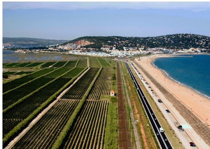
Figure I.14. Le Lido entre Sète et Marseillan après rénovation de dunes. Source: Thau agglomération
