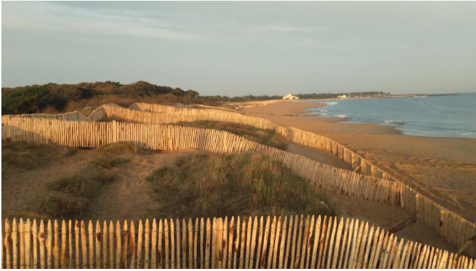
Figure I.17. Pose de ganivelles sur l'île D'Oléron. Source: ONF
