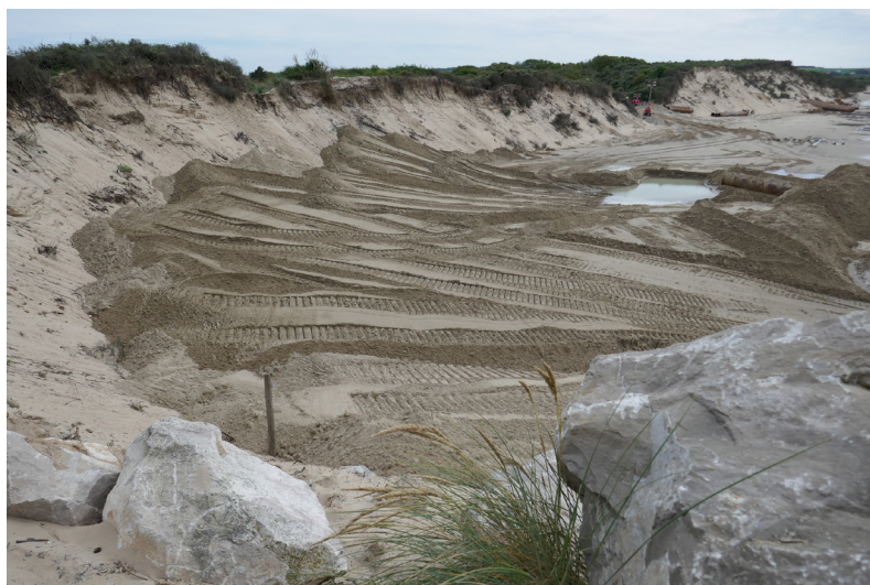
Figure I.16. Apport de sable sur une plage de Wissant.
