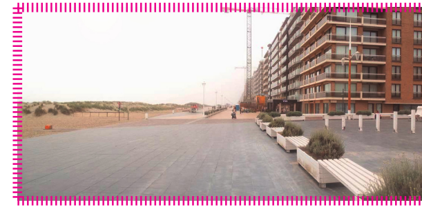
Front de mer Nieuwport
