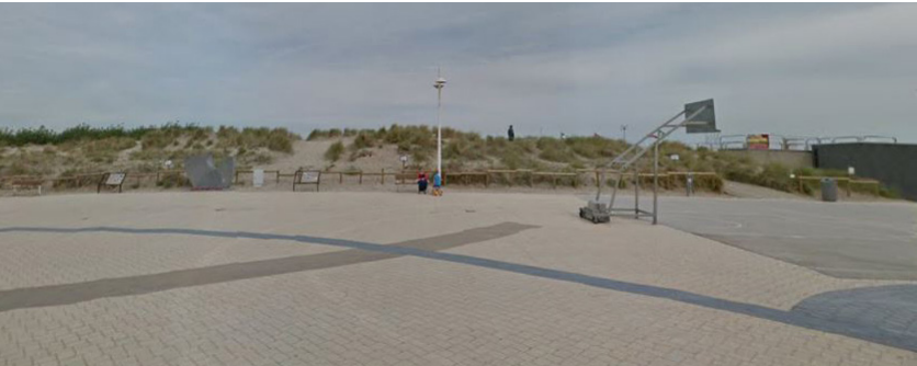
Fig 33 : Dune protégeant la digue de la Panne. Source : Google street view
