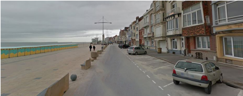
Fig 29 : Digue de mer à Malo-les-Bains. Source : Google street view
