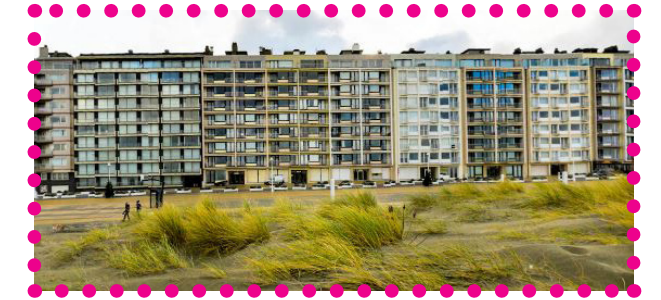
Front de mer Nieuwport
