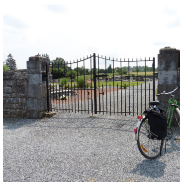
Figure 50: Portail de l'entrée coté extension cimetière
