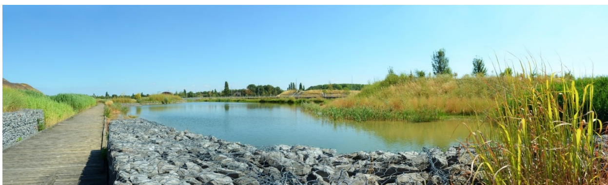
Photographie panoramique de la passerelle traversant les îles thématiques (Source : Touvron V.)
