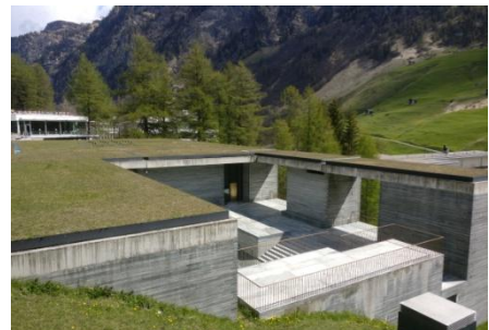
Figure 132 – Vue bassin extérieur
