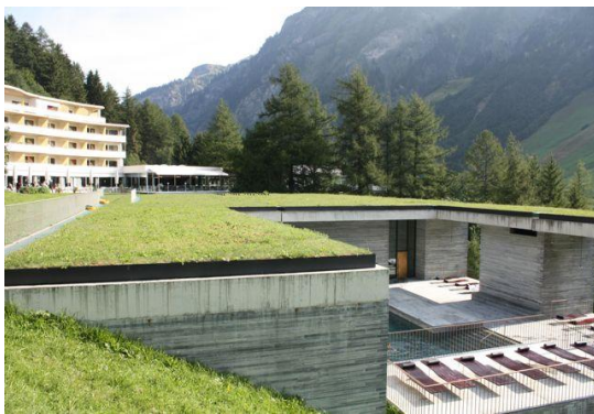
Figure 135 – Toiture plate végétale
