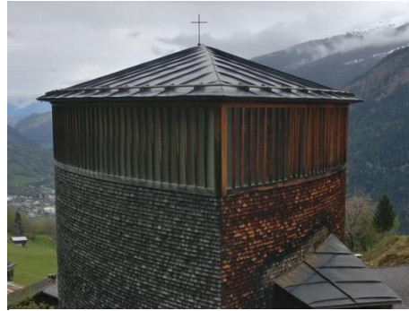
Figure 102 – Vue sur toiture, Zinc.
