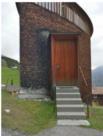
Figure 79 – Porte entrée, Chapelle Sainte-Bénédict.
