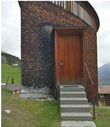
Figure 97 – Chapelle Sainte-B, entrée.
