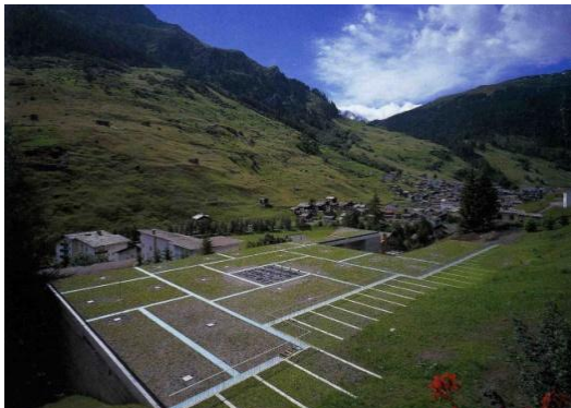
Figure 188 – Toiture plate végétale
