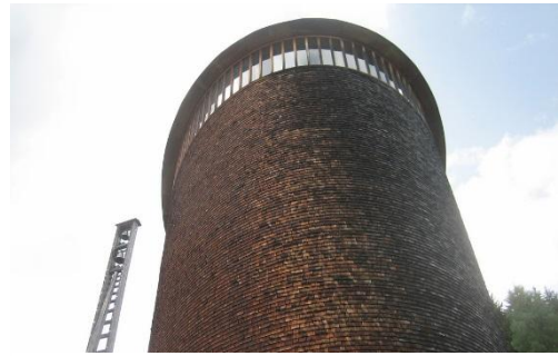
Figure 123 –vue façade Est.
