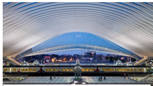
fig. 35 – S. Calatrava, Gare des Guillemins, Liège.
