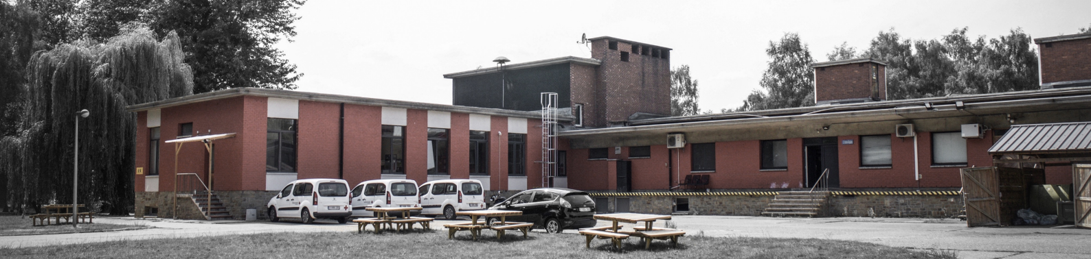
[FIG.5] Bâtiment central du centre « l'Envol » à Bierset.
