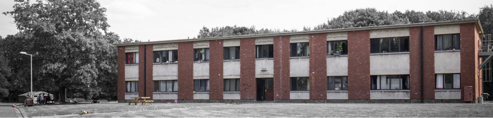
[FIG.7] Bloc de logements
