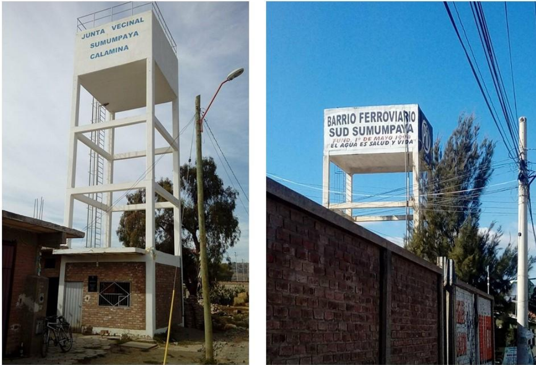
Figure 46 - Deux réservoirs haut dans lesquels est pompée l'eau des puits électriquement pour ensuite être distribuée dans le réseau, quartiers CALAMINA et SUMUMPAYA FERROV. SUR. - SOURCE : Photos personnelles
